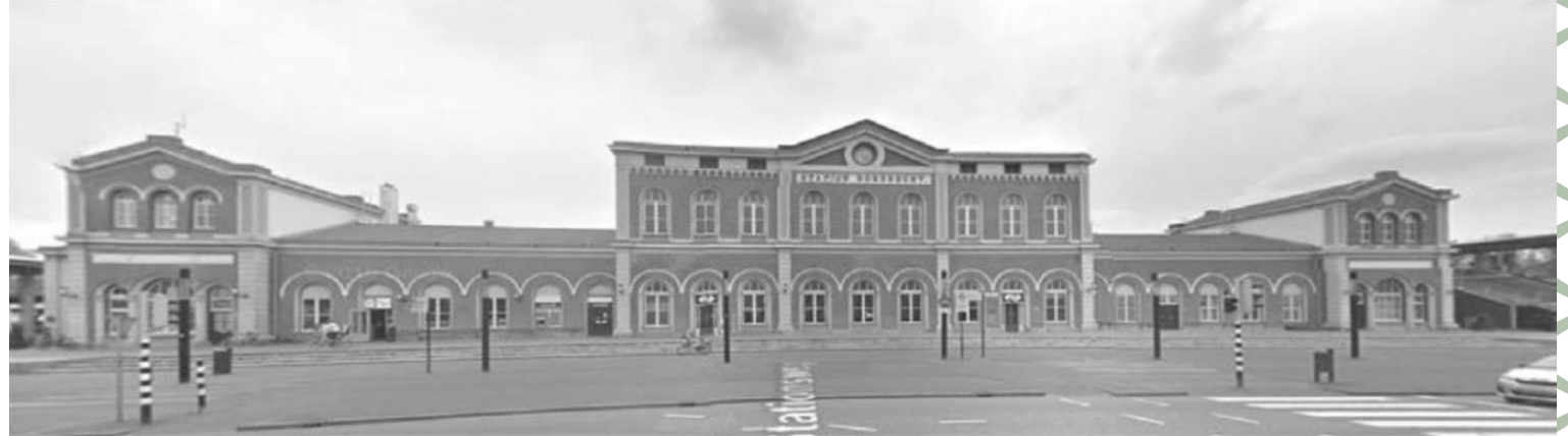
Station Dordrecht centrumzijde
