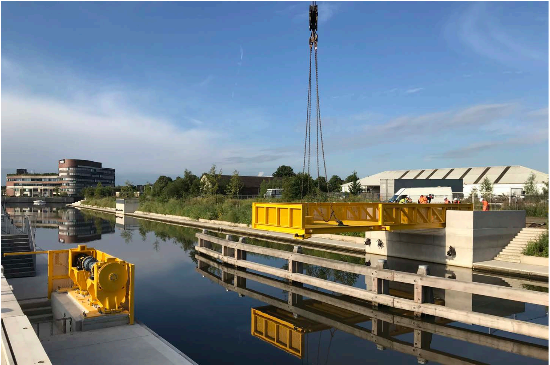
De plaatsing vast deel brug westzijde in balkon
