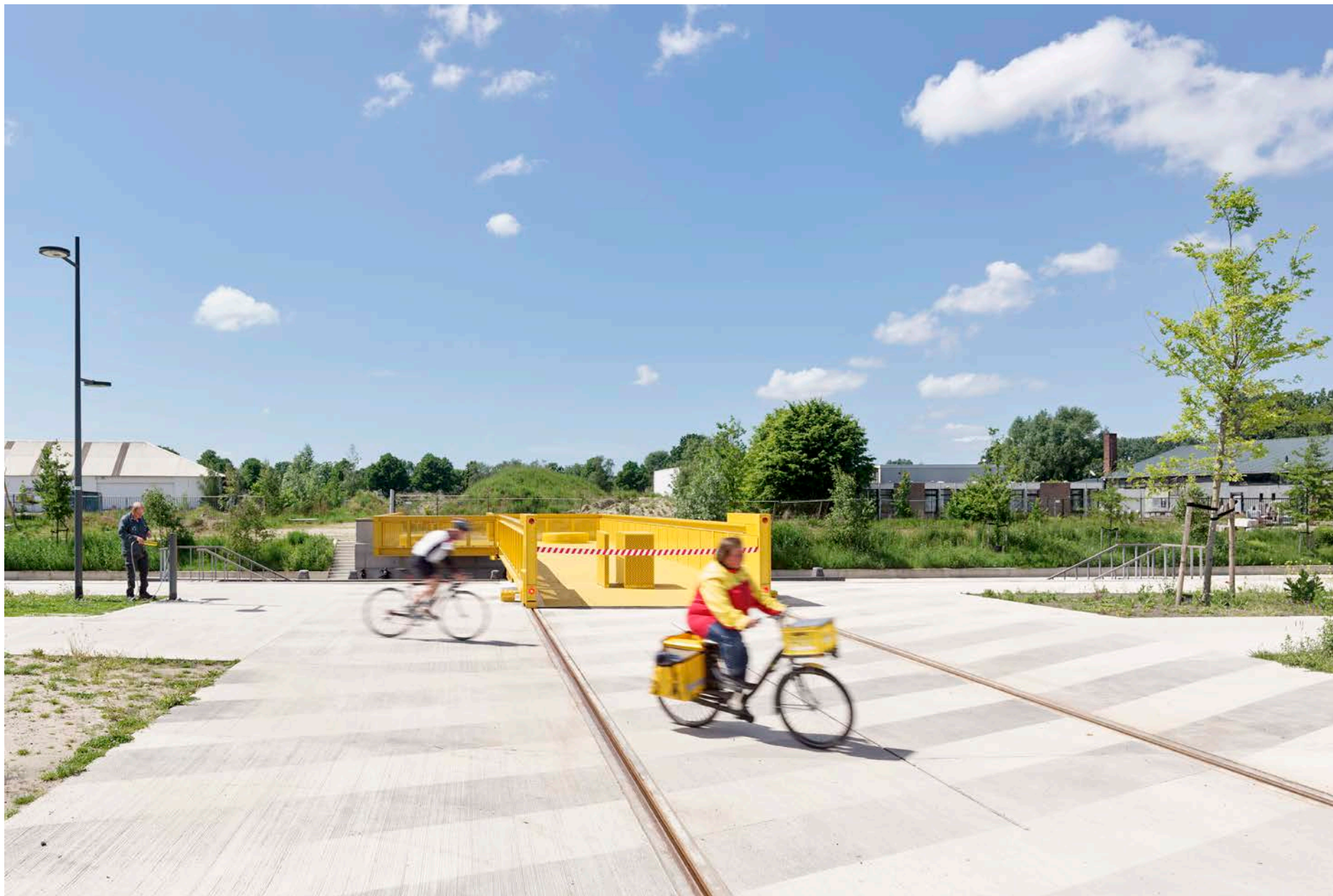
De aanlanding en rolruimte beweegbaar brugdeel oostelijke havendijk
