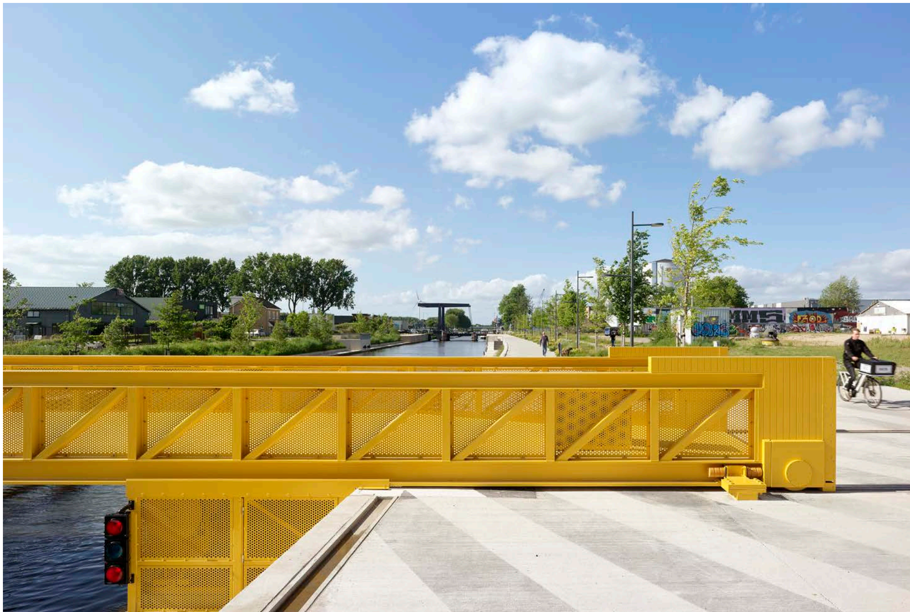
De aanlanding oostelijke havendijk met ballast in de kop van het bewegende brugdeel
