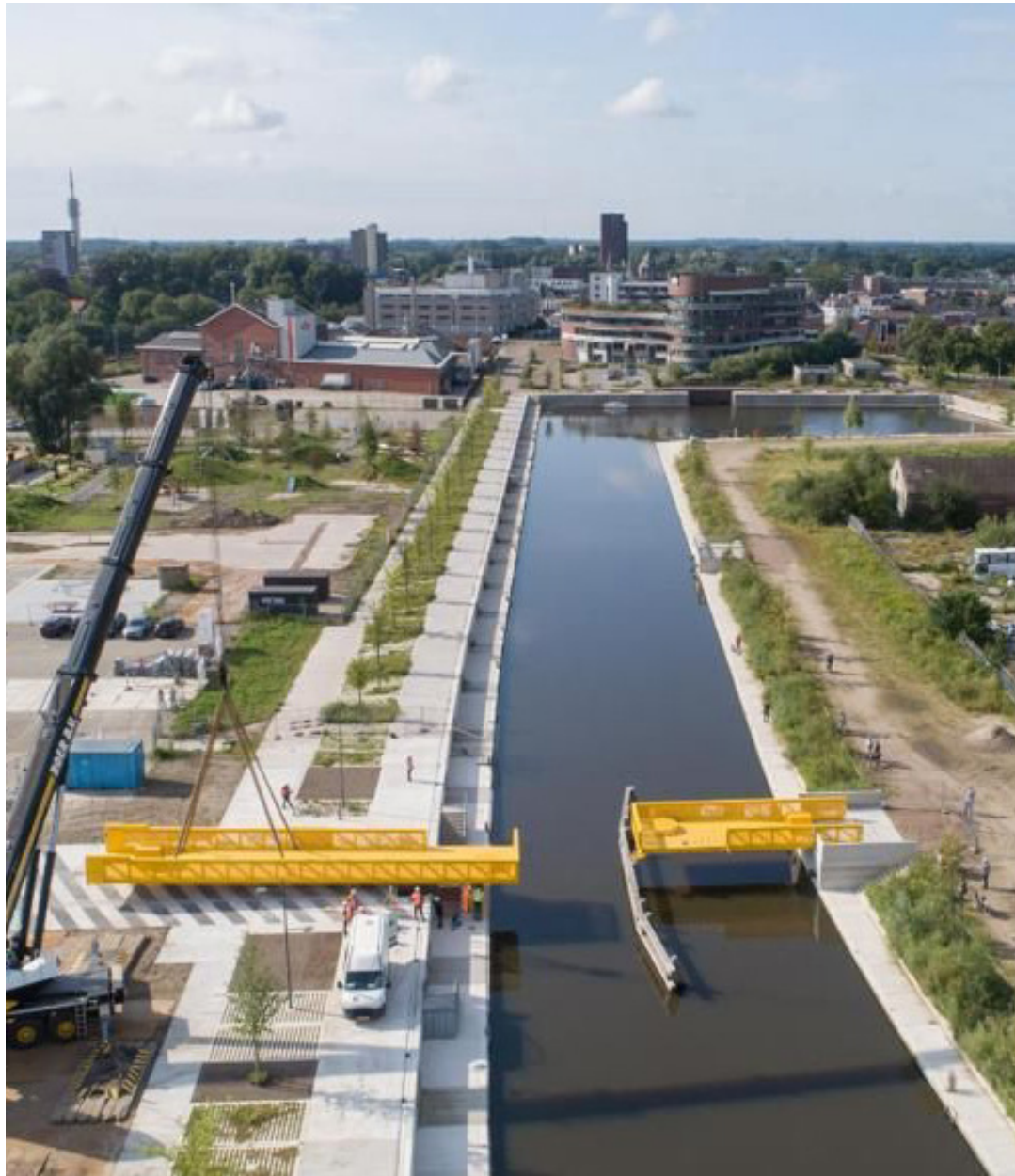
De plaatsing rollende brugdeel gezien vanuit het zuiden
