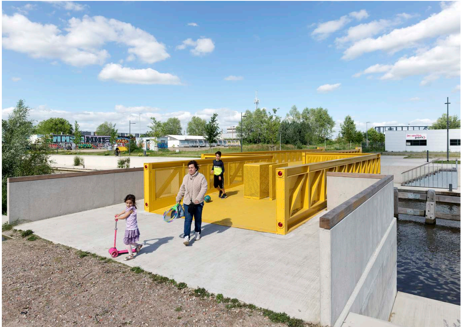
De aanlanding van de brug op westelijk balkon
