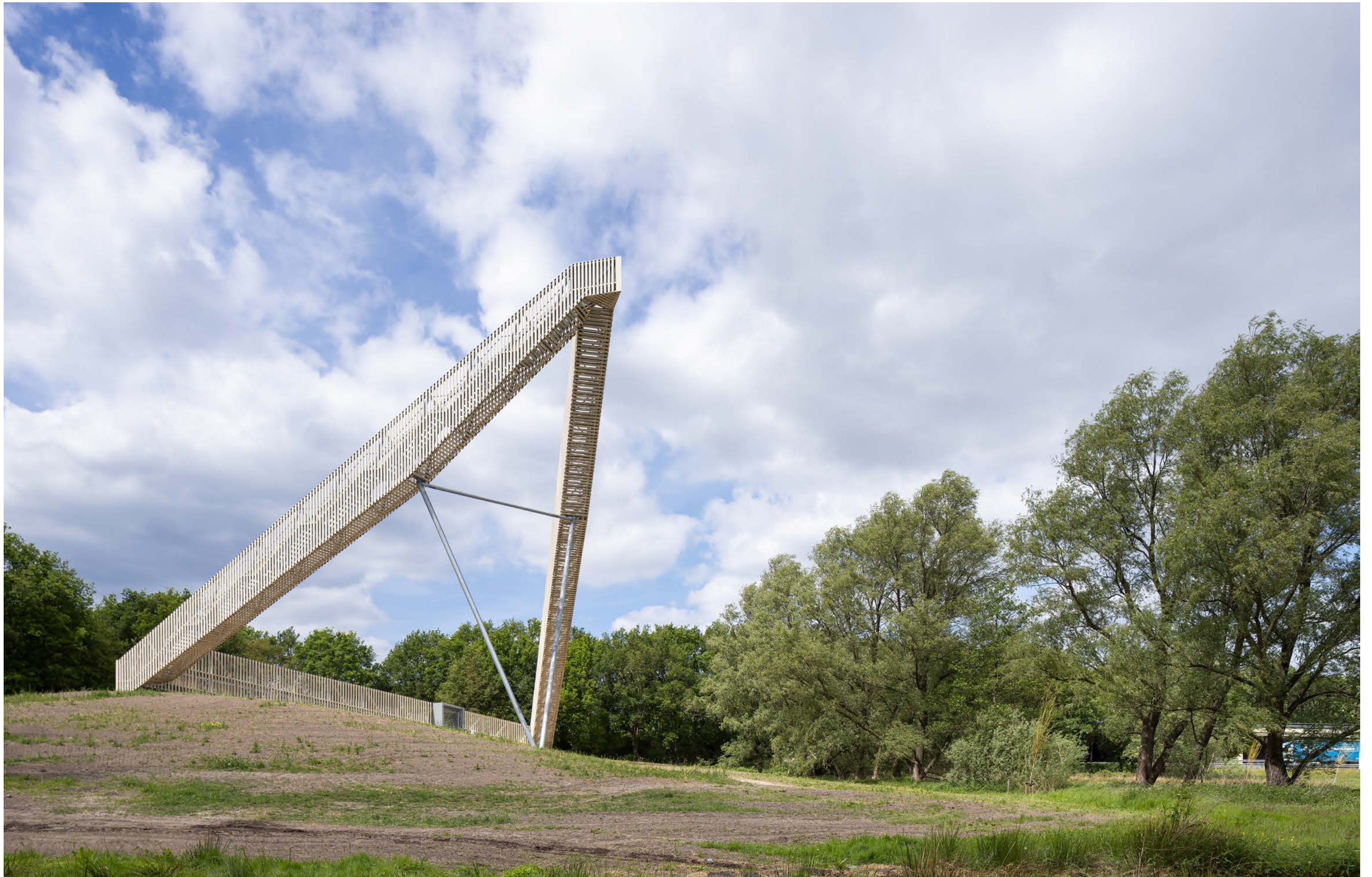
Uitkijktoren de Nieuwe Herdgang, Tilburg | ARCHITECTUUR MAKEN
