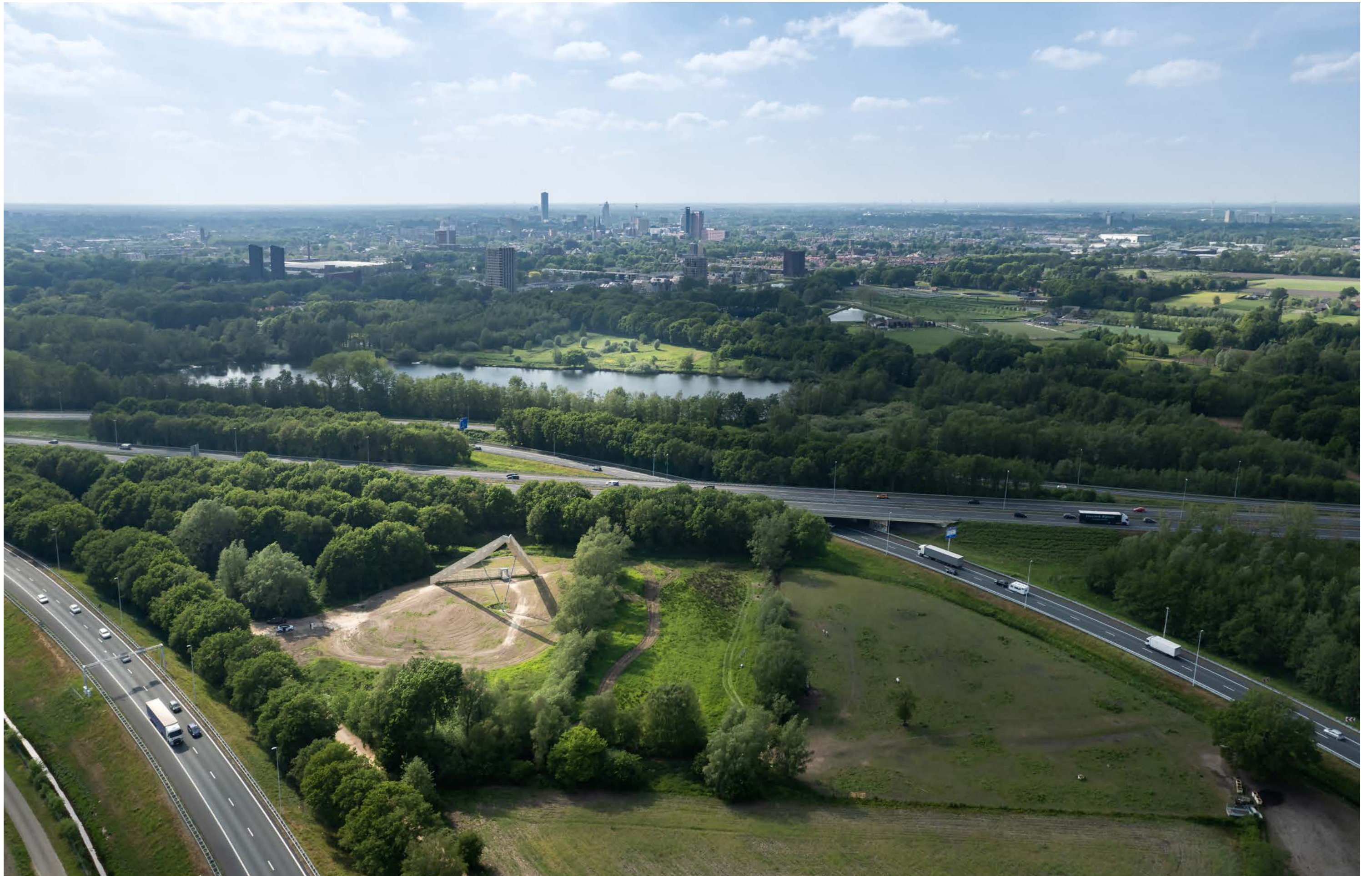
Uitkijktoren de Nieuwe Herdgang, Tilburg | ARCHITECTUUR MAKEN
