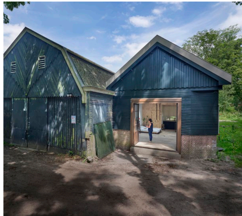
Bestaande toestand van de afgeschuinde kop, daarnaast de nieuwe situatie met de grote roestkleurige dubbele deur voor goederen naar het atelier.
