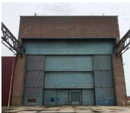
3. Recent buiten- en binnenaanzicht deuren Scheepsbouwloods.
