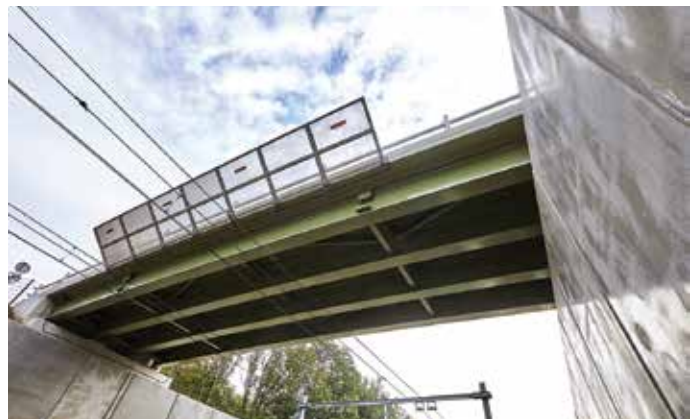
Onderzijde brugdek met gaasramen.
