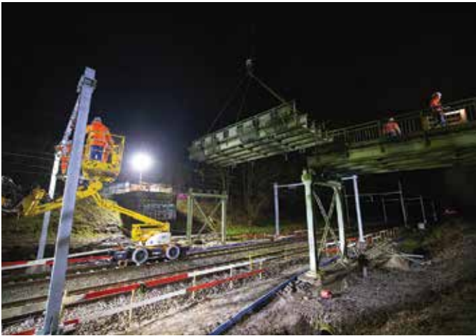
Demontage bestaande verkeersbrug.
