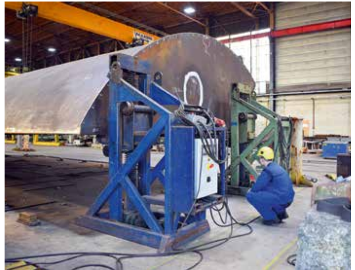
Opvijzelen van de deurconstructie om draaiarmen aan te kunnen brengen.
