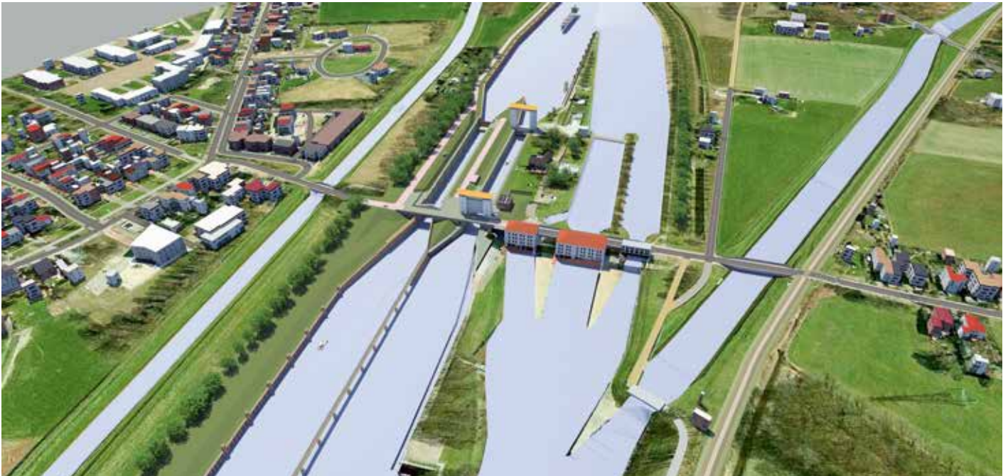
Sluiscomplex Eefde met links naast de bestaande historische hefportalen de nieuwe tweede sluisolk.
