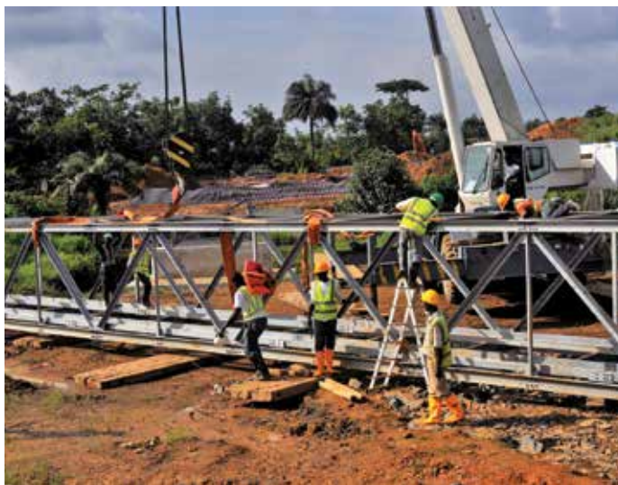
Kenmerkend is de afwezigheid van gesloten profielen van het type buis of koker.
