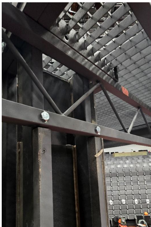
Detail balkonbevestiging vaste delen
