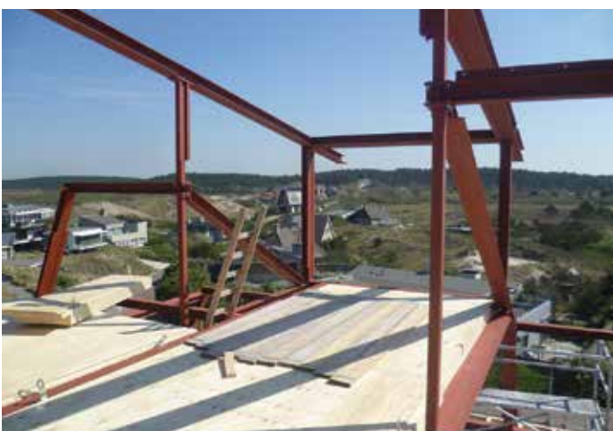
De constructie bestaat in principe uit evenwijdig geplaatste stalen spanten. De sporen dragen tegelijk bovenliggende vloeren.
