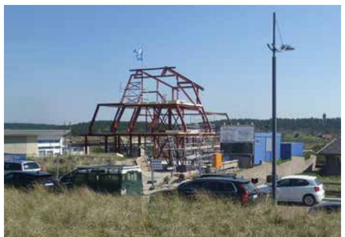
De staalconstructie wordt bijna overal weggewerkt in de schil en vloeren.
