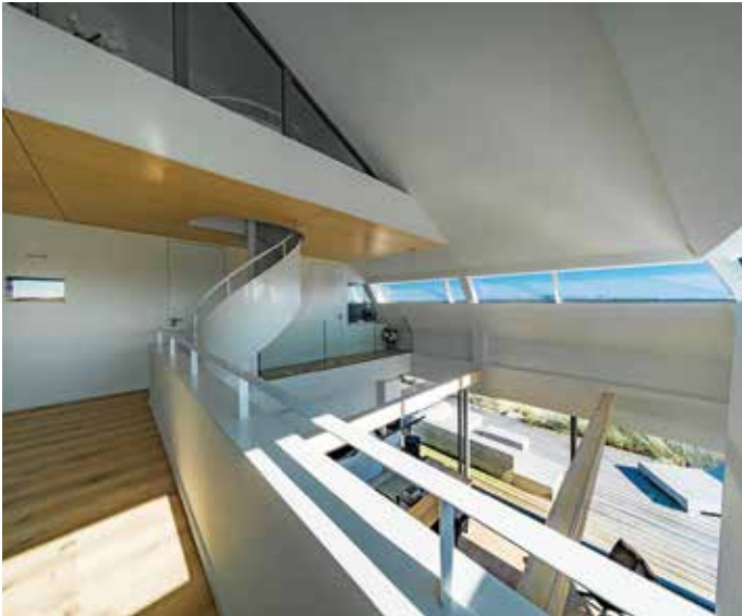
Omtimmerde trekstangen in de vide. In de kijkstroken een glimp van de spanten.
