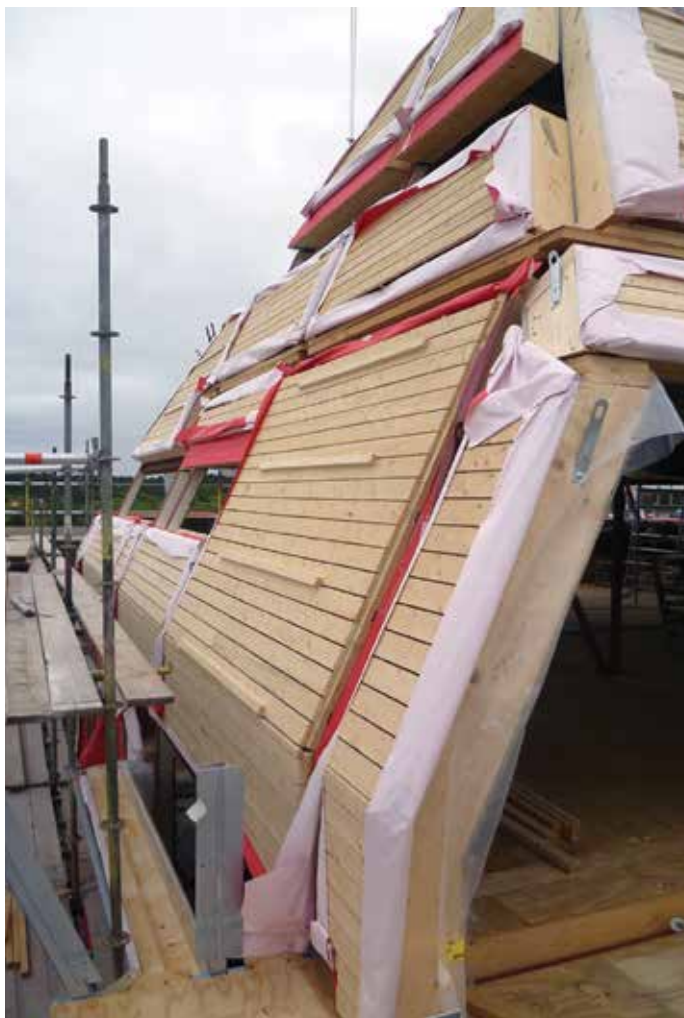
Geen goten, want die zouden snel vol zand zitten. Hemelwater stroomt langs de gevel af.
