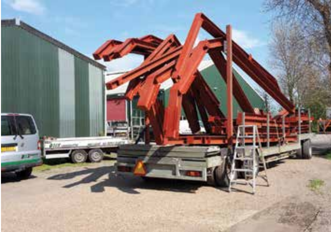
Prefab onderdelen vanuit Akersloot.
