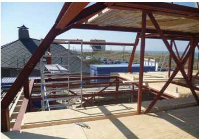
Overal doorsnijdingen, flinke overspanningen en weinig doorgaande wanden.
