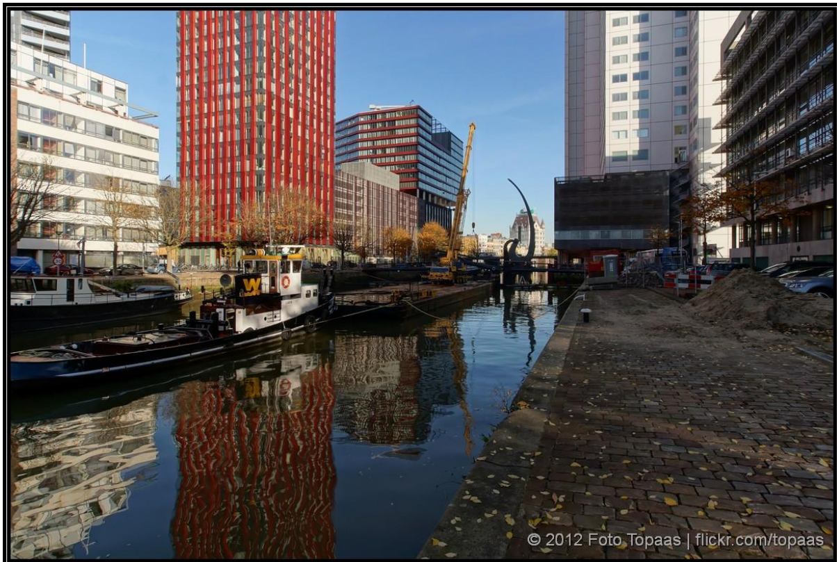
Fotos tijdens de bouw: mei 2012-april 2013
