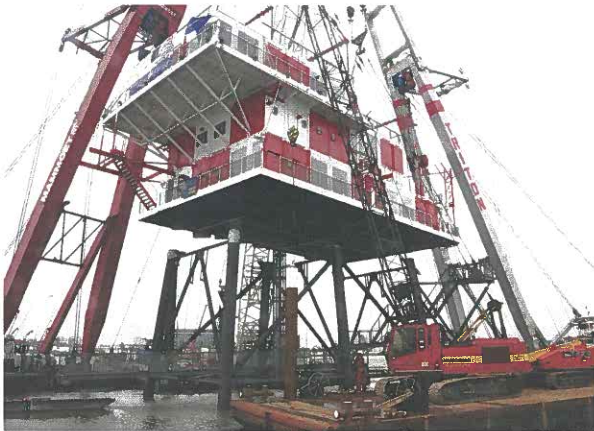
Met drie drijvende bokken werd het Rem-eiland op zijn nieuwe plek gelegd in de Amsterdamse Houthaven. Foto: Ronald Bakker
