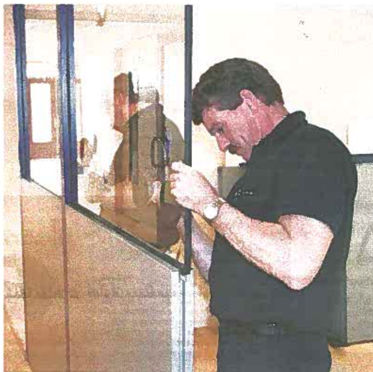
Het glas wordt in het onderste deel van het paneel geschoven.
