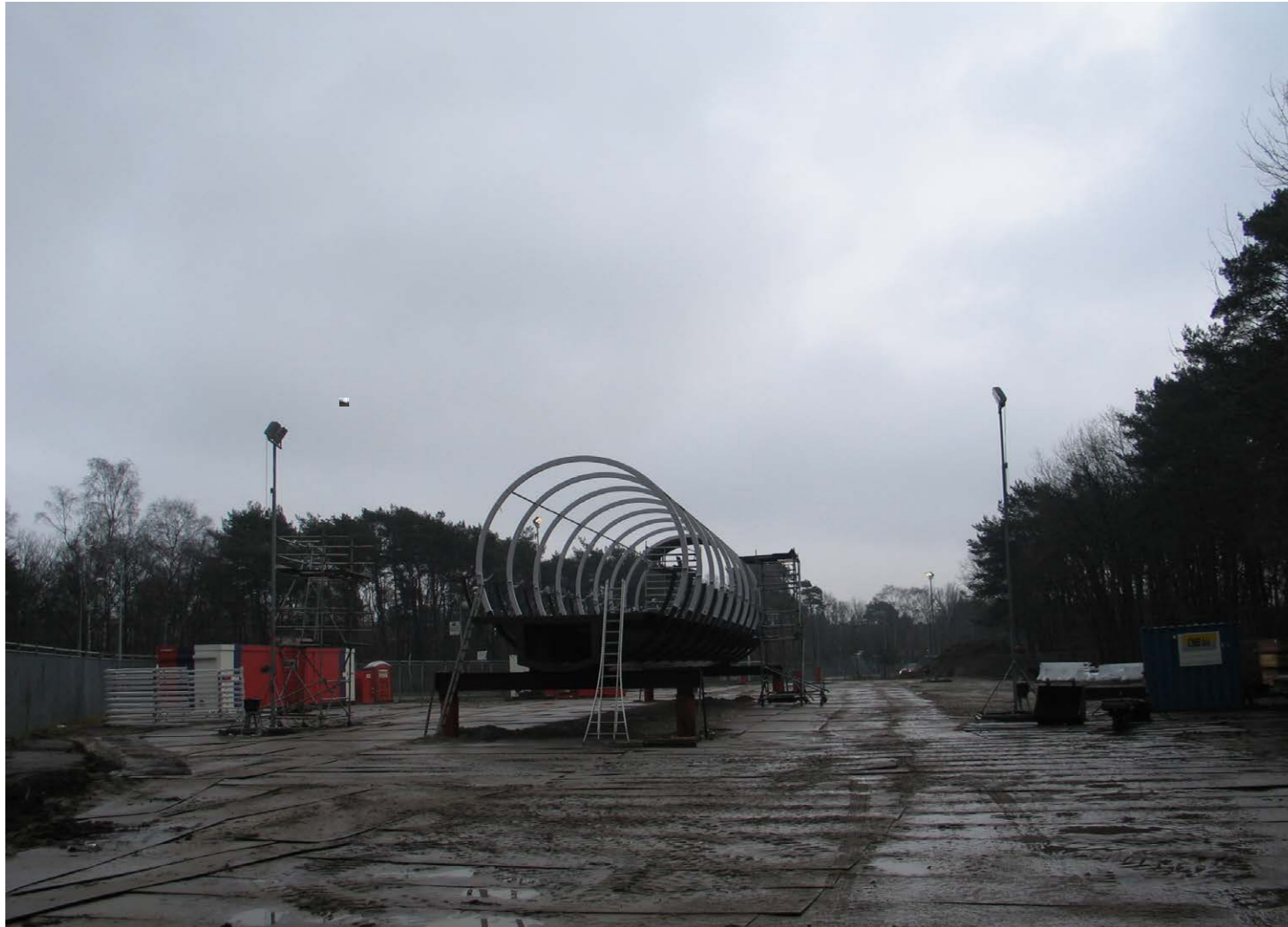
Voor de bouw van de Traverse is er voor gekozen om de Traverse in delen voor te bouwen op een afgesloten terrein in de buurt. Dit om de hinder voor de gebruikers van het Media Park, de Mies Boumanboulevard en het station zoveel mogelijk te beperken
