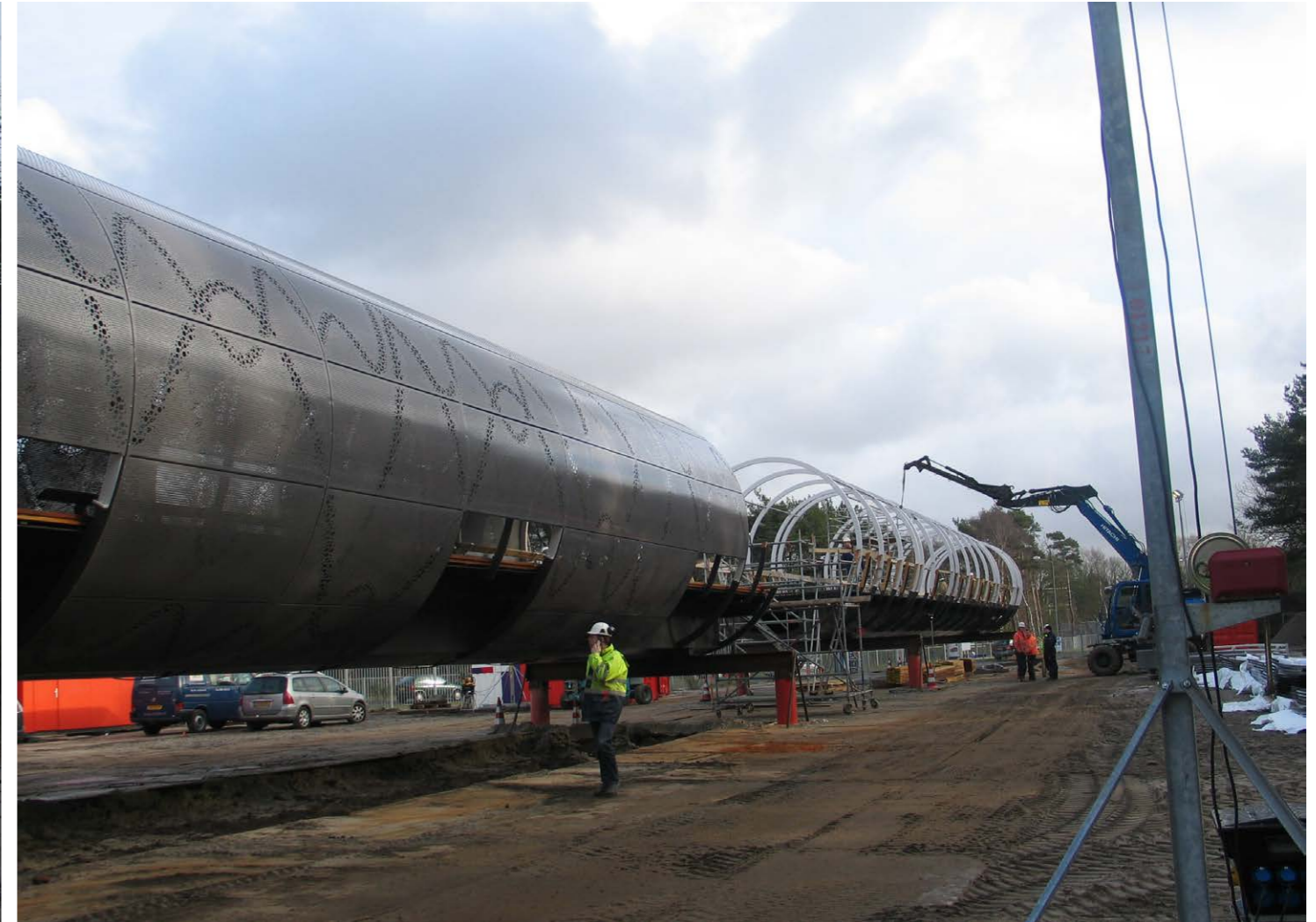
Voor de bouw van de Traverse is er voor gekozen om de Traverse in delen voor te bouwen op een afgesloten terrein in de buurt. Dit om de hinder voor de gebruikers van het Media Park, de Mies Boumanboulevard en het station zoveel mogelijk te beperken
