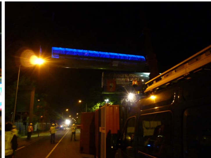
De delen, twee stuks, boven de Mies Bouman Boulevard en het station zijn in één buitendienststelling van vijf uur m.b.v. twee 500 tons-kranen geplaatst.
