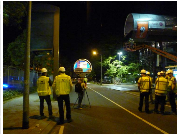
De delen, twee stuks, boven de Mies Bouman Boulevard en het station zijn in één buitendienststelling van vijf uur m.b.v. twee 500 tons-kranen geplaatst.
