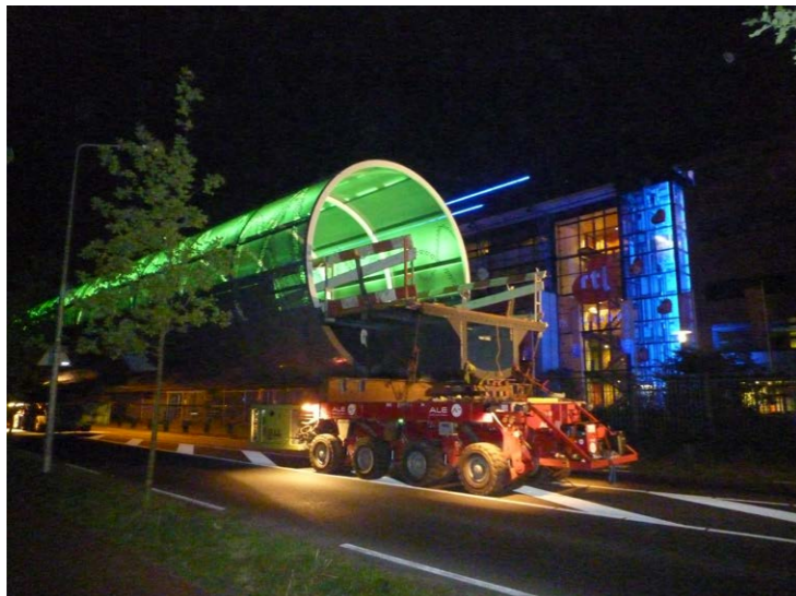
De delen, twee stuks, boven de Mies Bouman Boulevard en het station zijn in één buitendienststelling van vijf uur m.b.v. twee 500 tons-kranen geplaatst.
