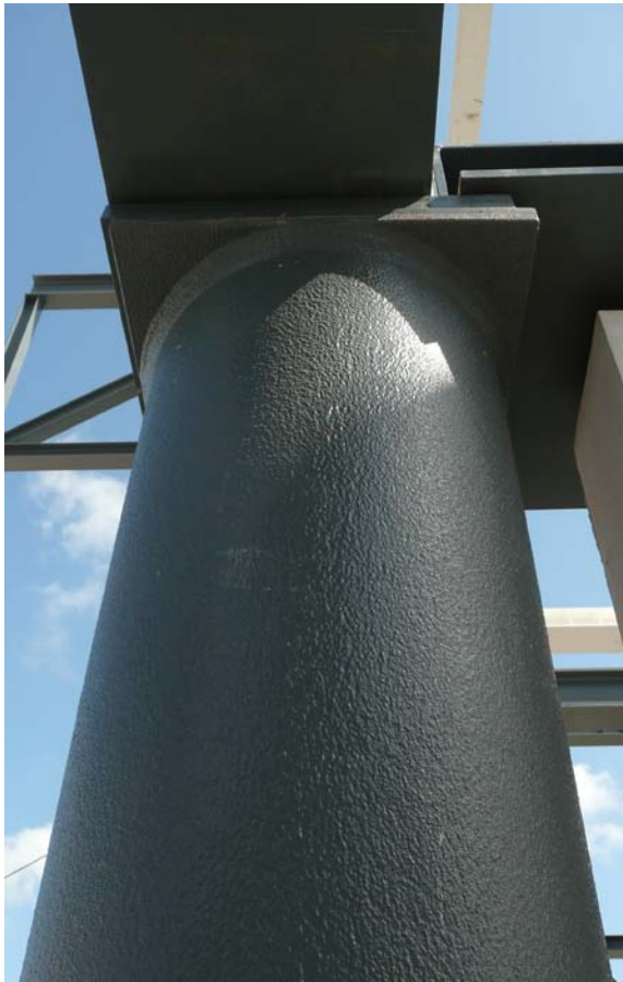
▼ Aansluiting V-kolom aan vakwerk
