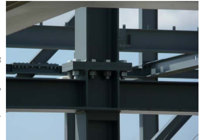
▼ Knoopverbinding vakwerkligger
