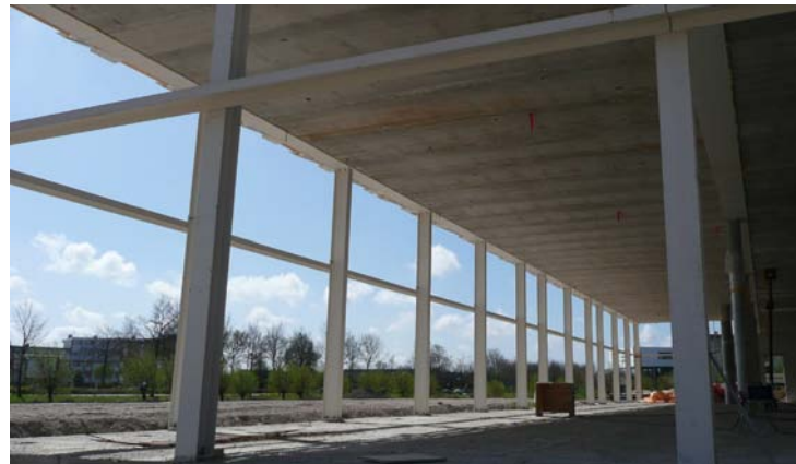
▲ Staalconstructie onderbouw
