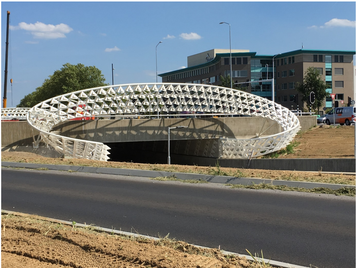
Foto 3: staalconstructie wordt gemonteerd (foto: de Blik)
