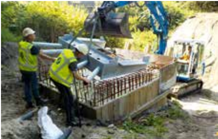
Aanbrengen juk na eerste betonstort.
