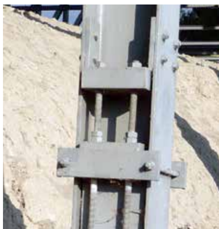
2. Bestaande kolom met uitschuifstelsel.
