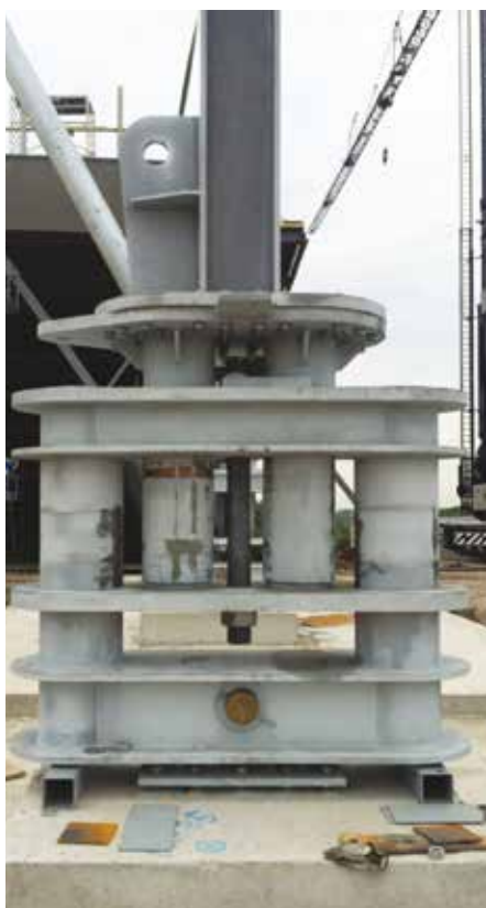
7. De uitschuifbare/vijzelbare portaal/kolomvoet in montagesituatie. Het draagkader is tijdelijk ondersteund, zodat de portaalkolom verticaal kan worden gemonteerd. De centrale geborgde as onder de ophangstaf vormt het scharnierende draaipunt waarmee het draagkader met de rotatiebox is verbonden.
