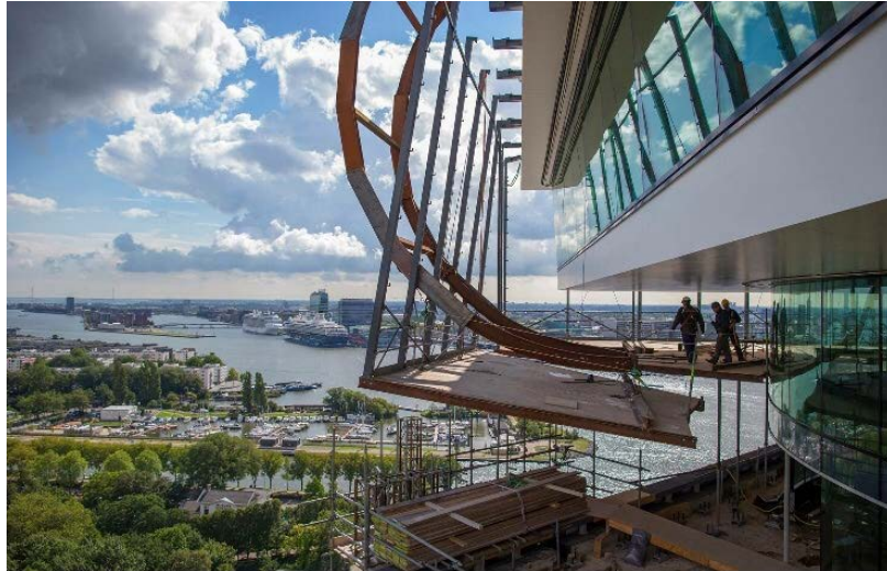
Speciale beugel om hangsteigers te demonteren
