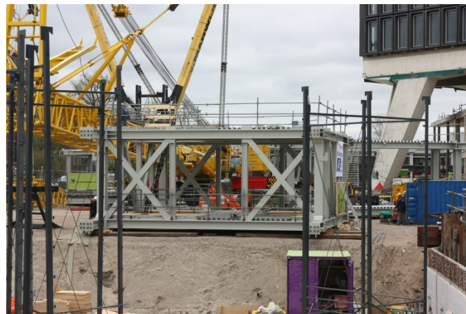
Segment 1 op de bouwplaats gemonteerd
