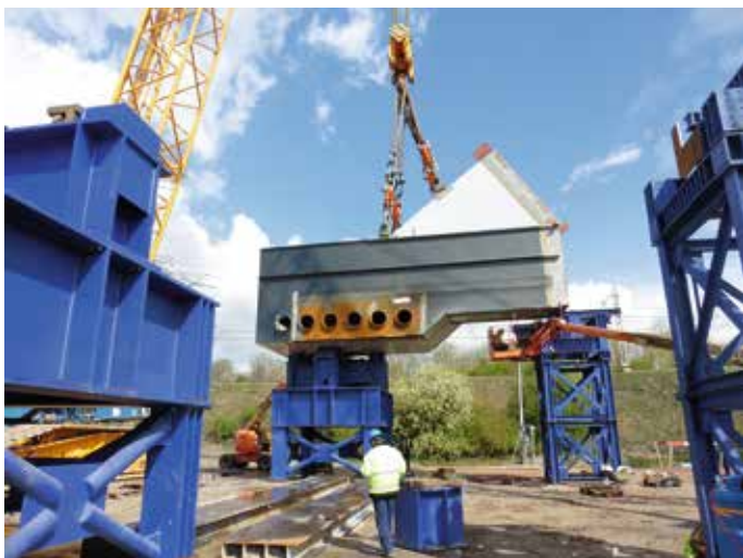
Plaatsing booggeboorte op de bouwplaats.
