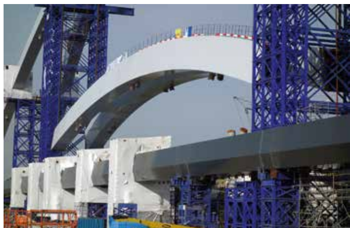
Seriematige samenstelling van 24 hoofdliggersegmenten...
