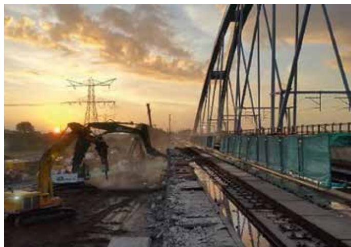
Sloop betonnen kokerbrug terwijl nog twee rijstroken beschikbaar blijven.
