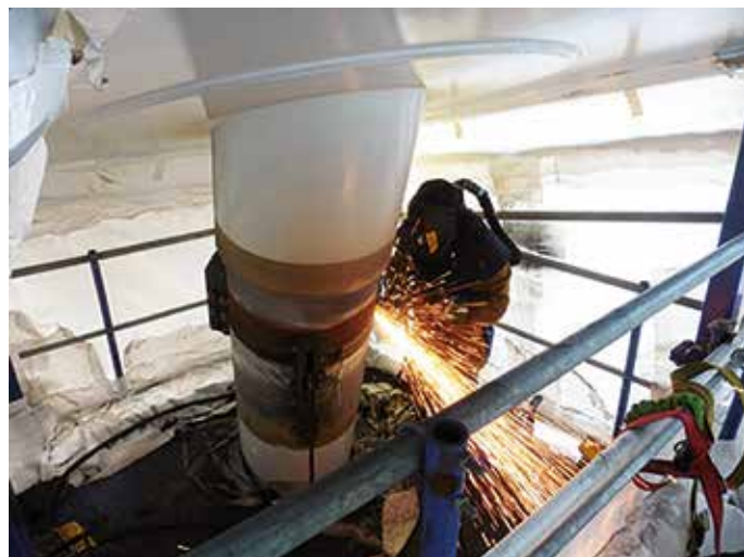
Lassen van een eerste diagonaal op de bouwplaats.
