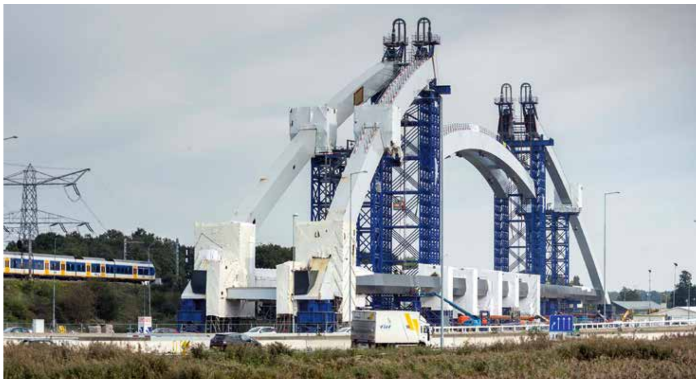
Inhijzen middenstuk van de boog op 12 oktober 2015 (boogdeel 100 m lang en 1.200 ton).
