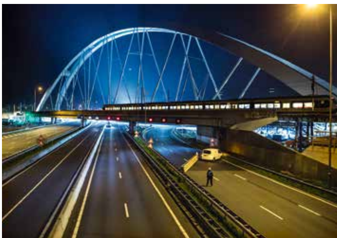
De brug ligt op locatie, maar de trein rijdt nog over de oude spoorbrug.
