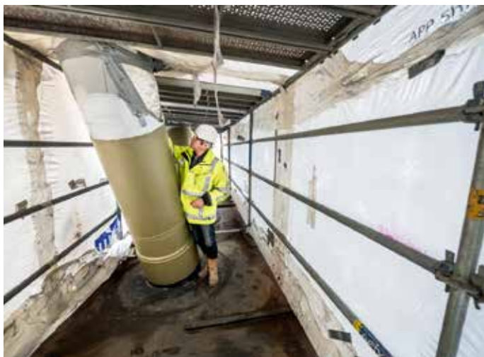
Enkele diagonaal uit buisprofiel S355 van 55 mm dik voor winddynamica.
