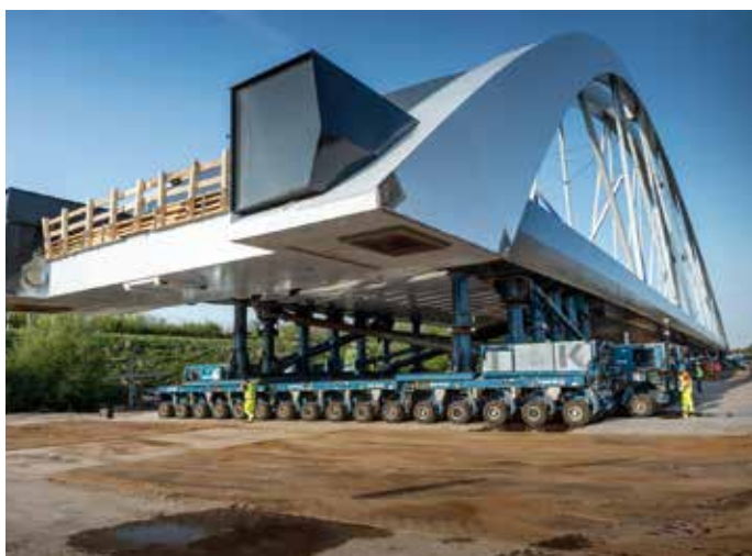
Hulpconstructie op de SPMT's met opleggingen onder de hoofdliggers.
