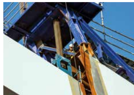
Hulpconstructie voor inhijzen middelste boogsectie.
