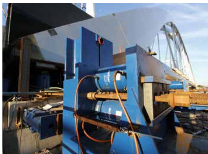
Krachtsinleiding bij het vijzelen is opgenomen in het ontwerp.
