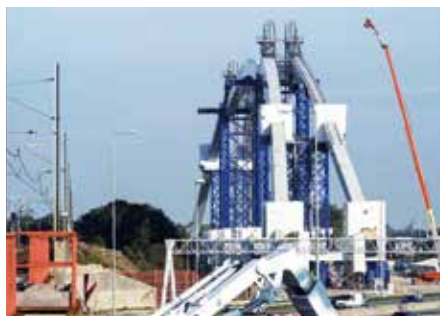
Speciale voorzieningen voor laswerkzaamheden.
