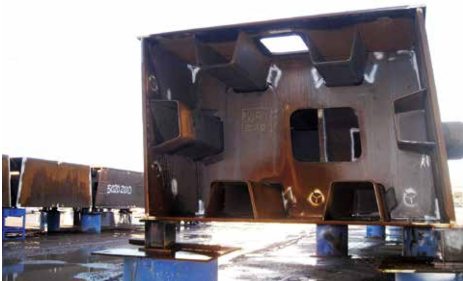
Boogdoorsnede met mangaten en de boogkoppelingen op de achtergrond.
