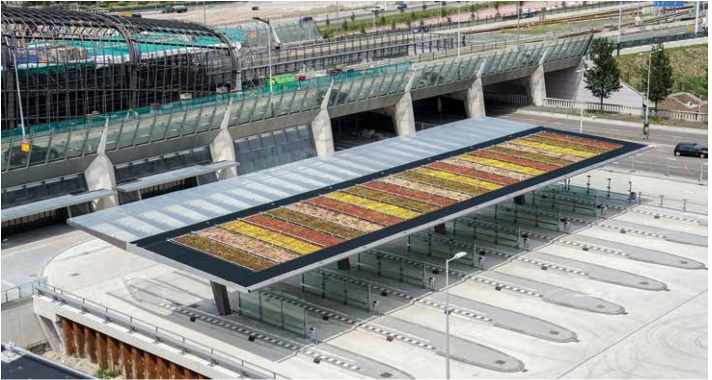
Sedumvegetatie en transparantie aan bovenzijde van de luifel.
