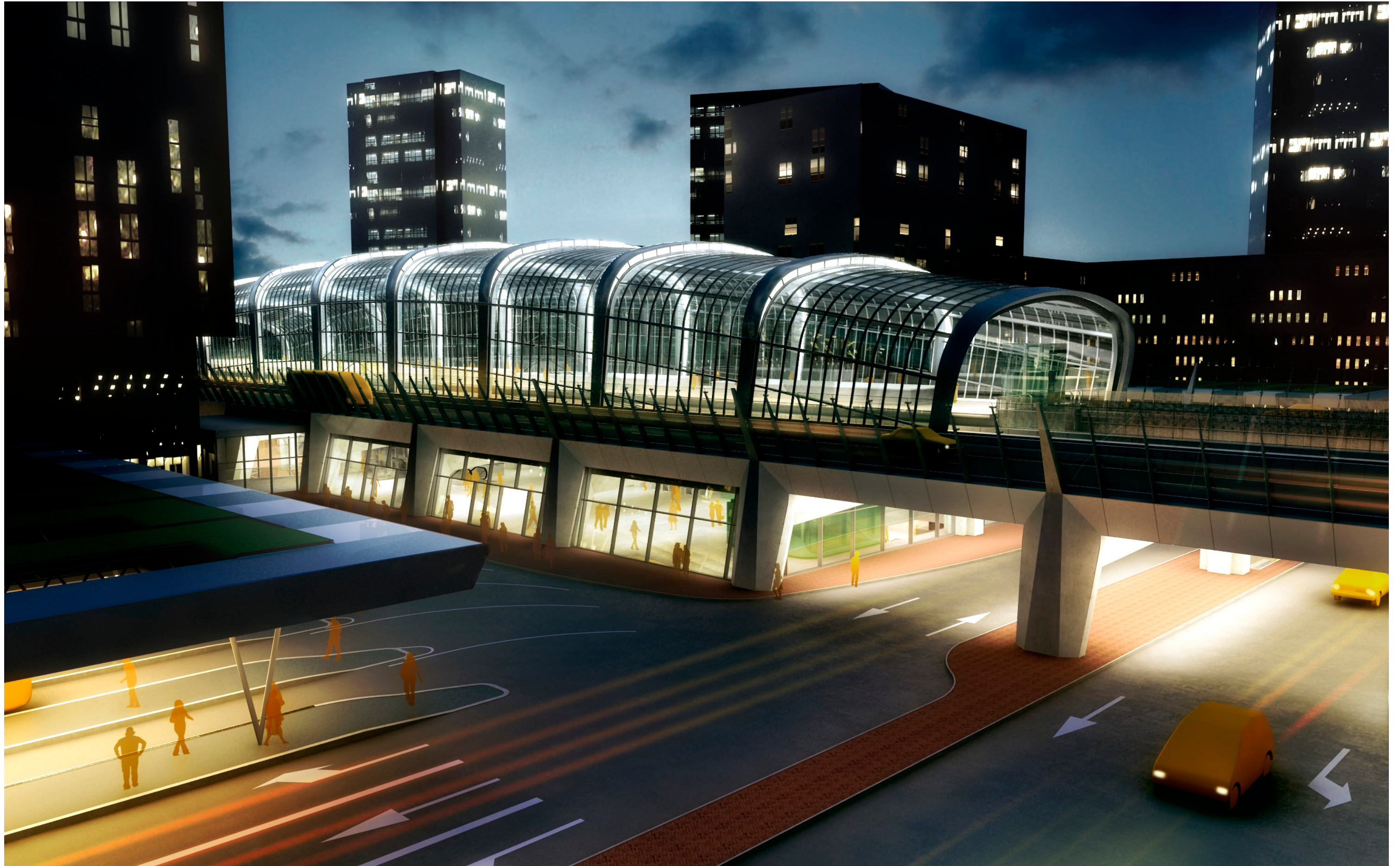
Impressie Grote kapconstructie bij nacht
