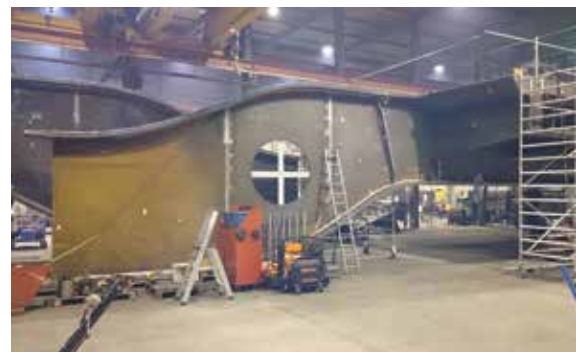
Na conservering worden de delen aan elkaar gelast en afgewerkt.
