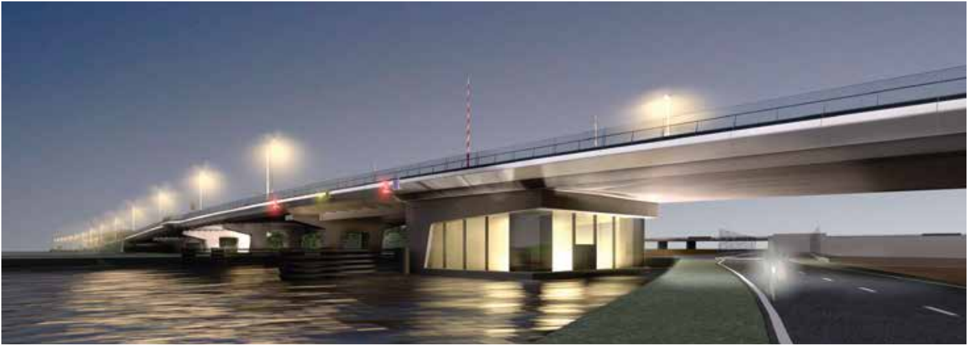
In de 500 m lange en 10 m hoge brug moest een beweegbaar deel worden opgenomen gezien de functie in de Staande Mastroute.
