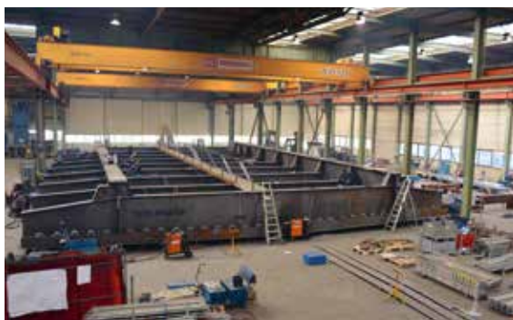
Het val is in vier delen gebouwd.
