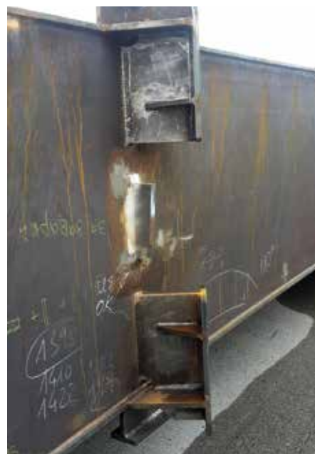
Tijdelijke oplegging voor montage voorbouwlocatie.
