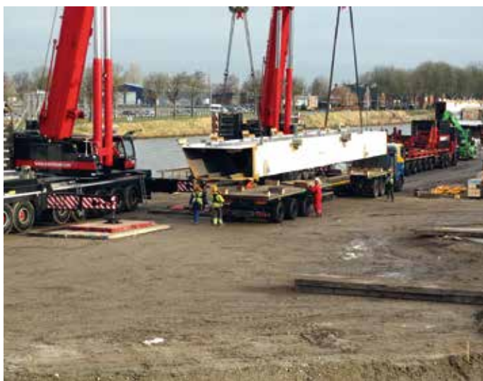
1. Oktober 2016: plaatsen van de eerste hoofdliggers op de voorbouwlocatie.
