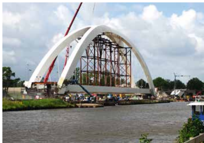
6. Mei 2017: verwijderen hulpconstructie voor gereed maken transport.
