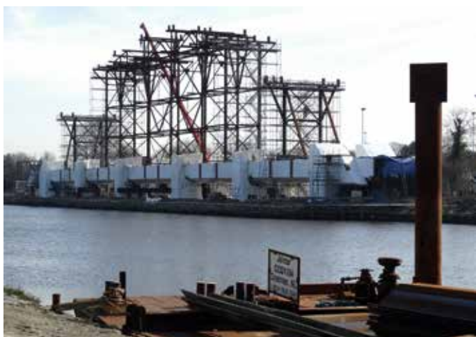
3. Februari 2017: alle tijdelijke hulpconstructies voor samenstellen boogdelen.
