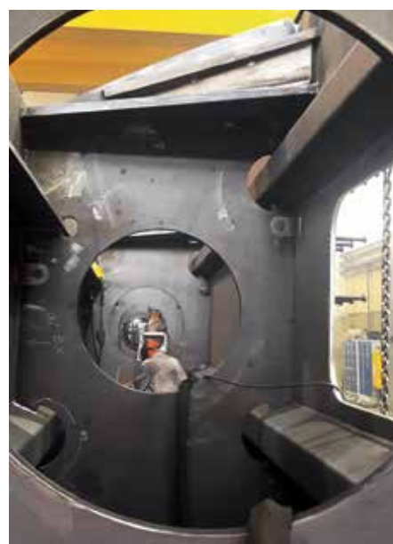
Laswerkzaamheden binnenzijde hoofdligger.
