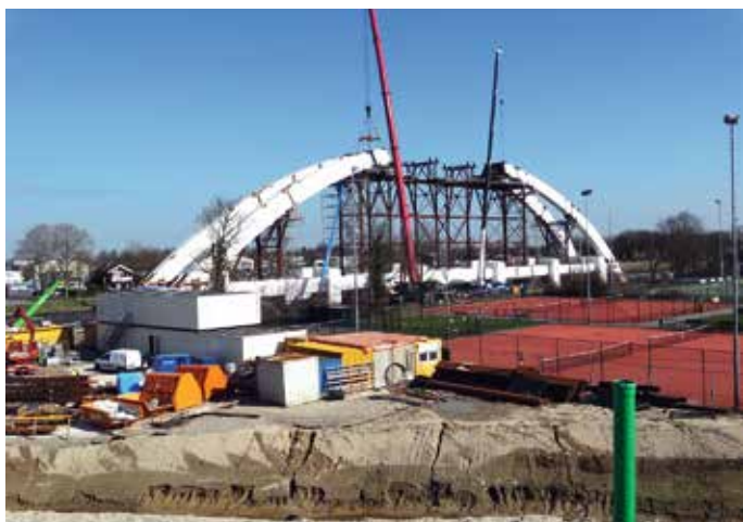
5. April 2017: plaatsen laatste boogdelen.
