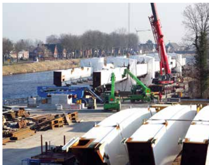
2. December 2016: plaatsen en lassen van de aansluitende hoofdliggers.
