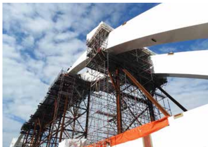
4. April 2017: trappentorens voor het lassen van de boogdelen.
