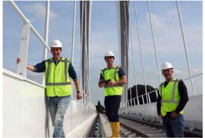
Laatste check met de architect (midden) voordat de trein er overheen mag.
