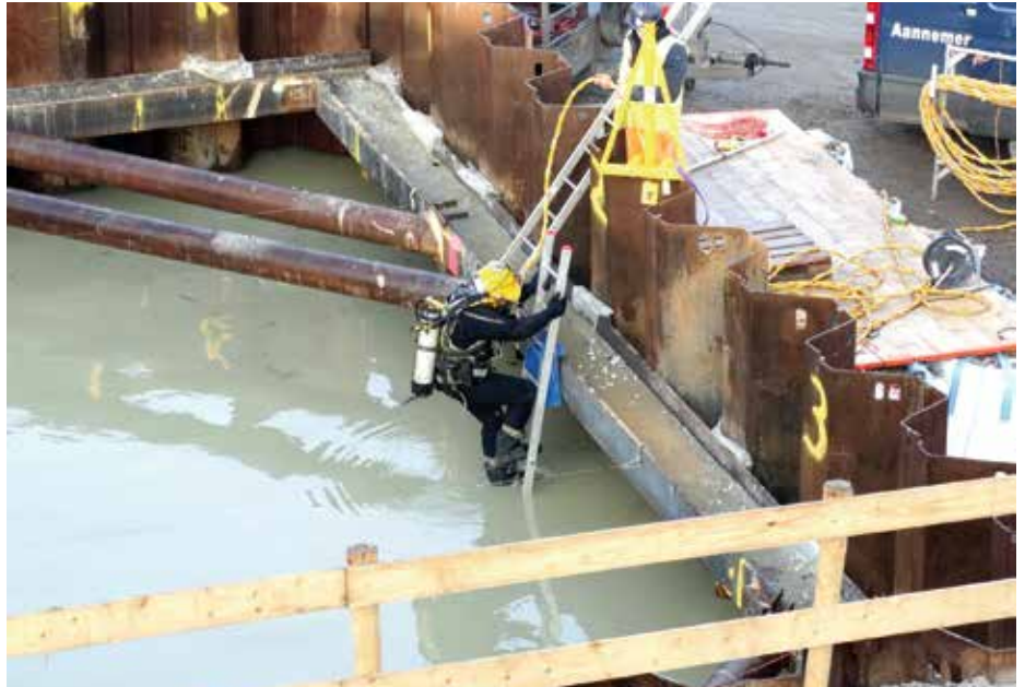
Tijdelijke bouwkuip voor fundatie met 1.000 kuub onderwaterbeton gewapend met staalvezels en korven.
