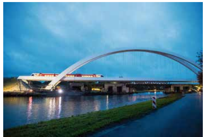
De staalconstructie is opgebouwd uit rechte en enkelvoudig gekromde staalplaten.
