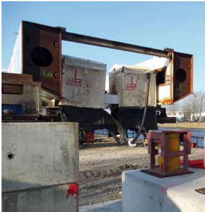
Assemblage dwarsdrager tussen hoofdliggers op voorbouwlocatie.
