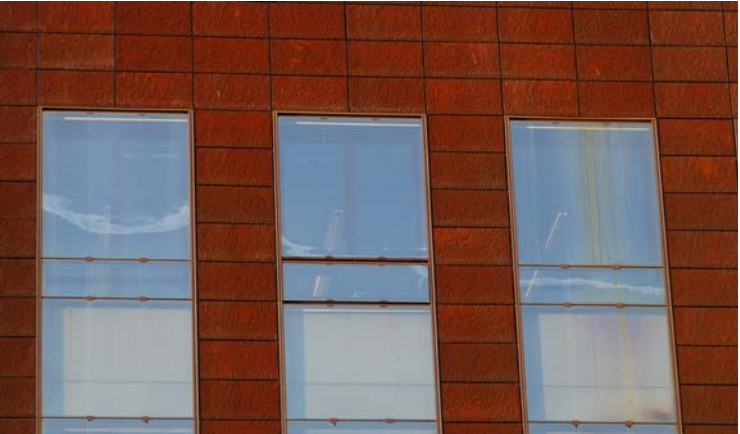
Vervolgens druip het vieze lekwater lang na de regenbui nog steeds over ruiten, droogt op en laat niet wasbare en onherstelbare sporen na
