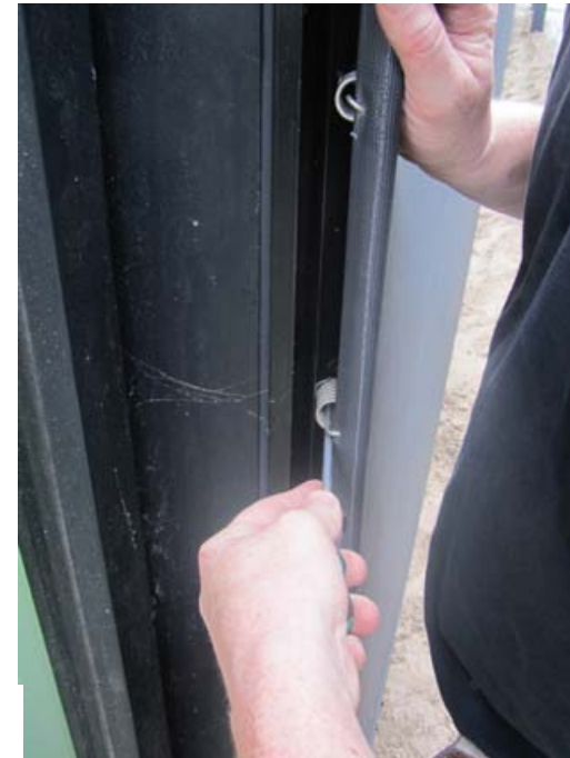
de veren om het staalprofiel aanbrengen
