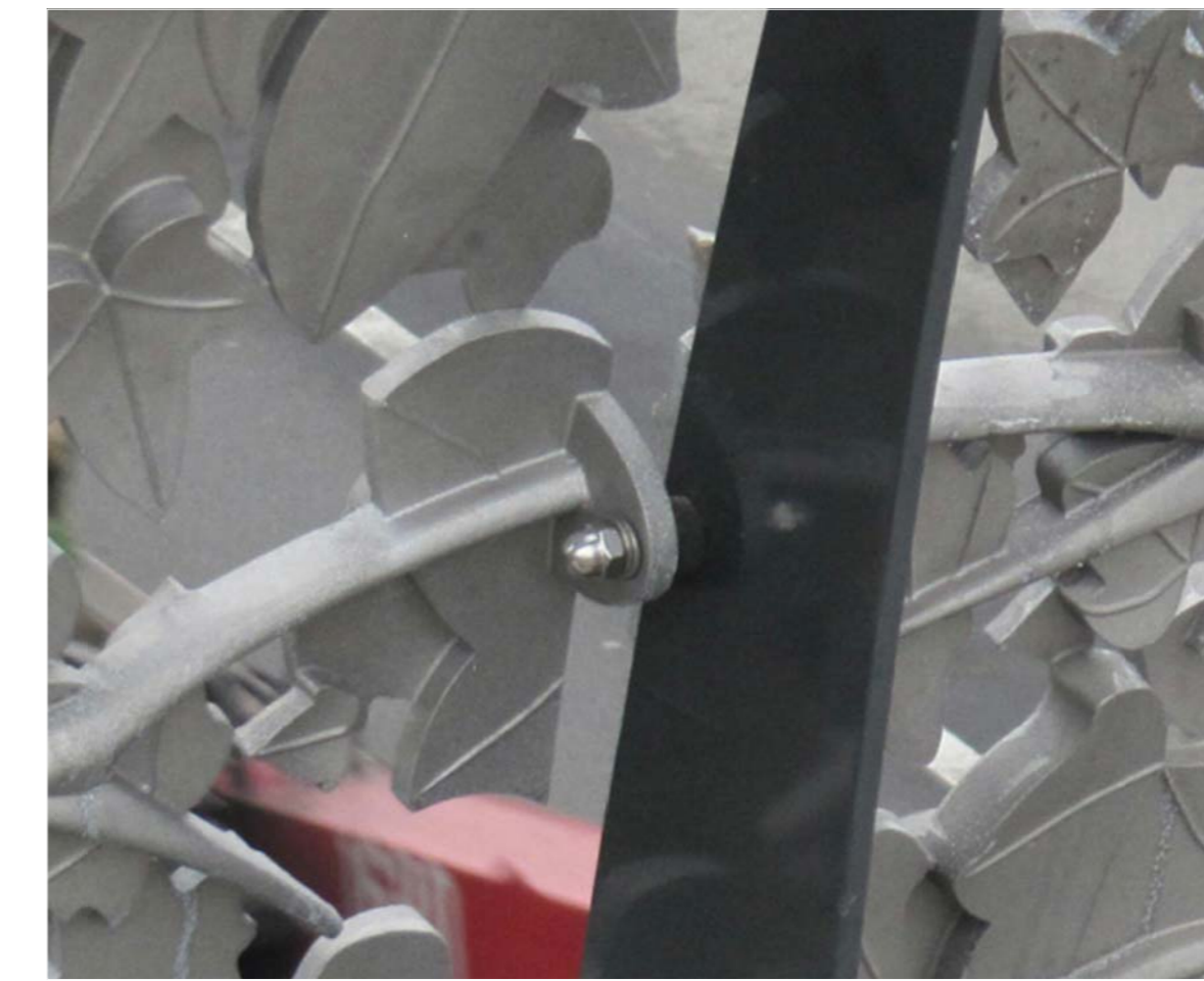
Referentie RVS bouwverbinding Hedera aluminium gietelement, viaduct Nieuwe Leeuwarderweg, Noorderpark, Amsterdam
