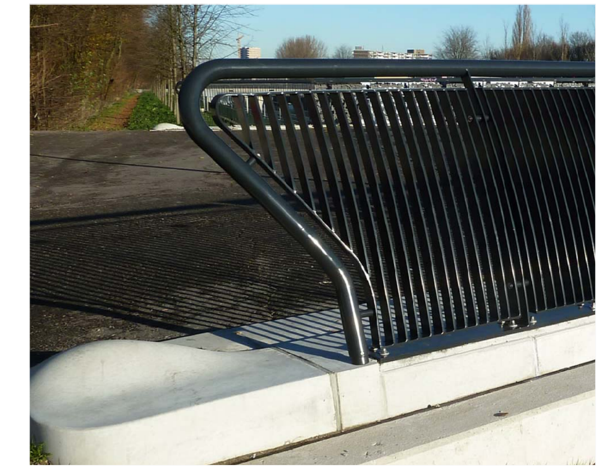
Referentie Spijlenhekwerk Nieuwe Leeuwarderweg, Noorderpark, Amsterdam
