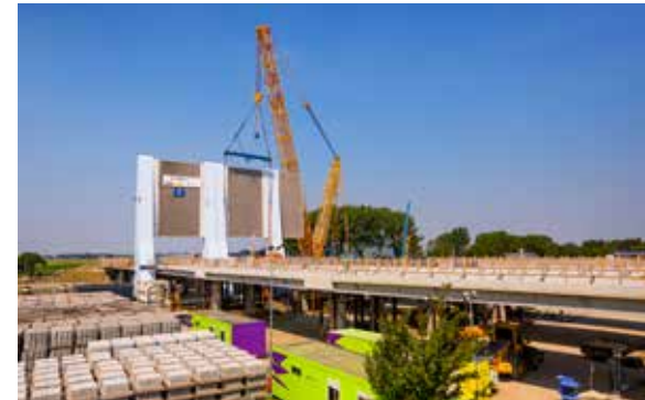
Bouwers hijsen de twee vallen (brugdekken) in de brug.
