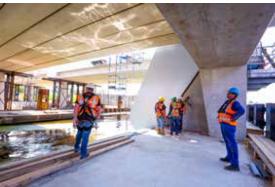
Het team is druk bezig met de groenblauwe watertuin met bamboe vlonders en het plaatsen van een bank onder de brug.
