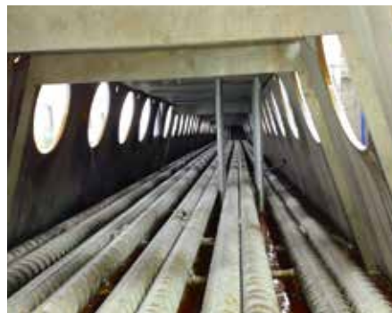
Stalen schotten zijn in het inwendige van de ligger gelast voor de doorstapeling van kolommen.
