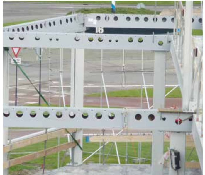
Tijdens het leggen van de kanaalplaten is geen onderstempeling nodig.
