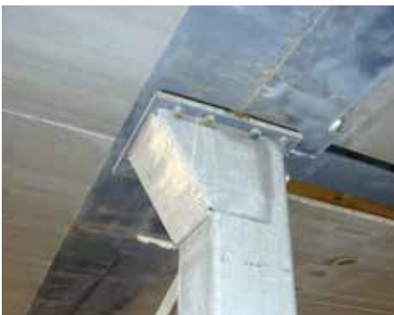
Uitgebouwde kolom bij dubbele staal-betonligger ter plaatse van een dilatatie.
