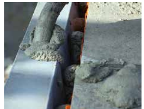
Aanbrengen van de betonvulling in het staalprofiel.
