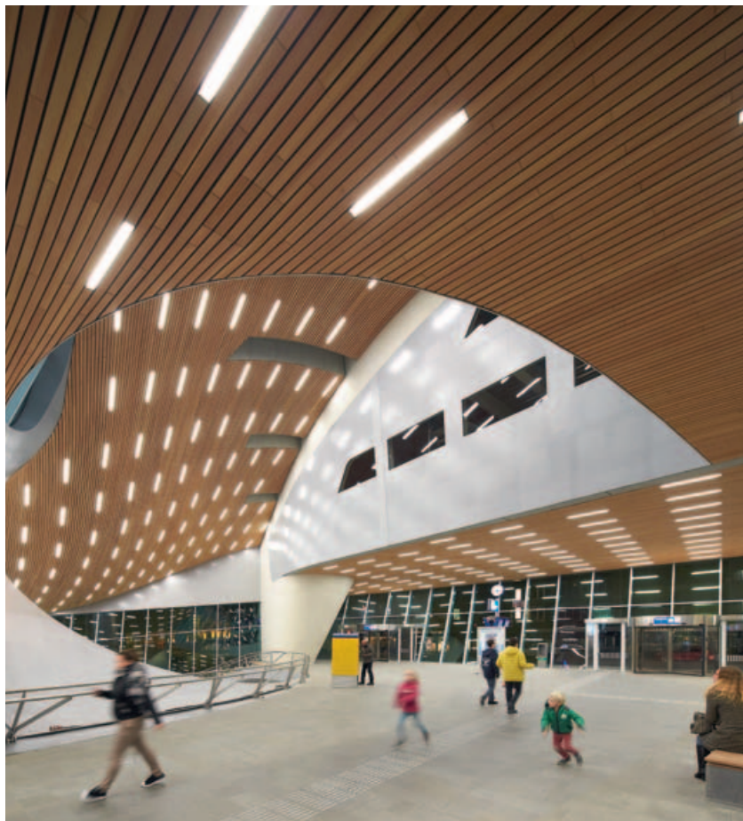
Het met houten latten beklede plafond bestaat uit speciaal behandeld oregon pine en voldoet aan de brandklasse-eisen.
