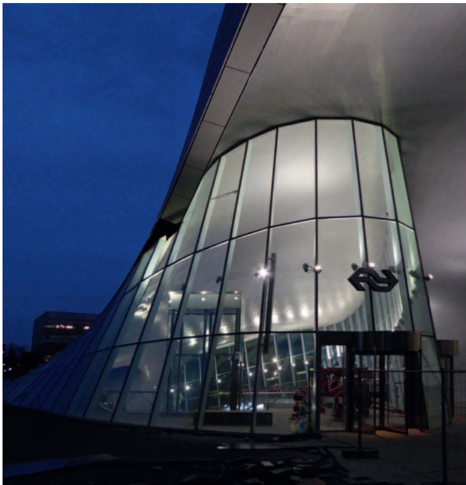
In de glooiende gevel is koudvervormd isolatieglas toegepast. (Foto: Josine Crone)
