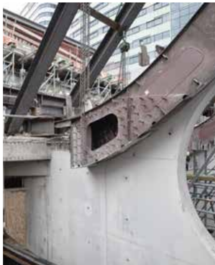
20a. Aansluiting op betonpenanten (nat)...
