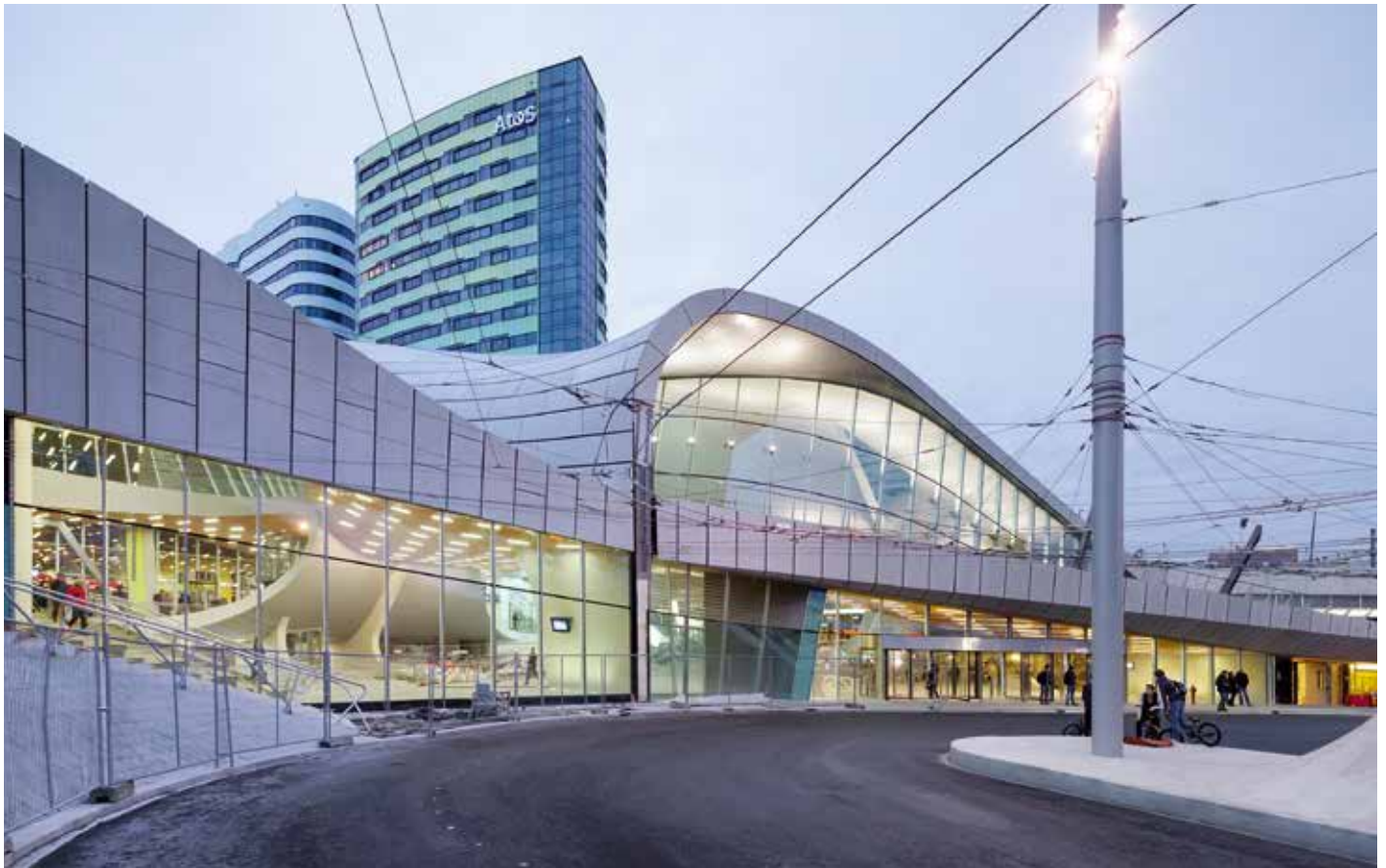
De dakrand is bekleed met 40 mm dikke gevelpanelen van microbeton. In totaal gaat het om 1540 dak- en gevelpanelen geproduceerd met stalen mallen.
