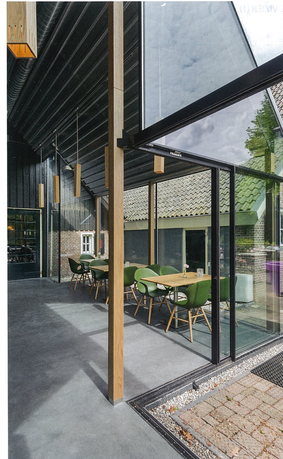
8. De stalen kokers worden bekleed met hout voor een natuurlijke inpassing in de bosrijke omgeving.
