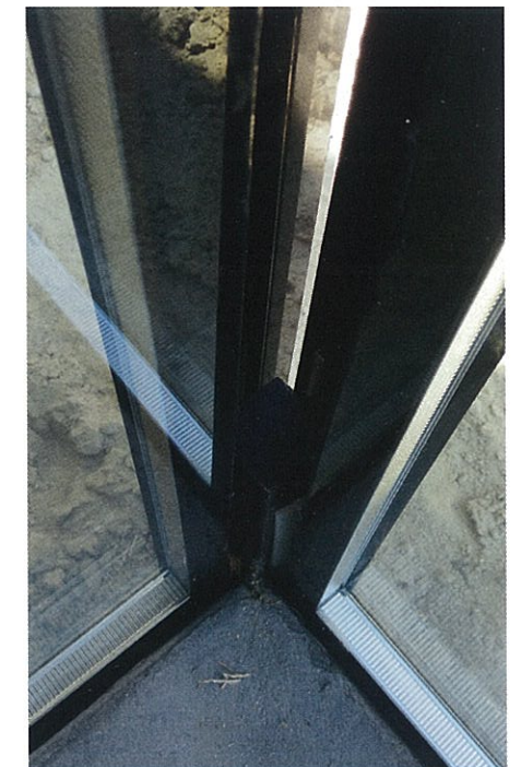
10. Nog niet afgewerkte hoekaansluiting.
