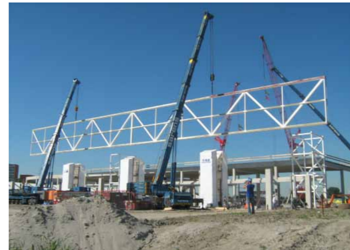
Het aantal lasverbindingen op het werk is geminimaliseerd. Deze zijn in de fabriek voorbereid en in lasten uitgevoerd.
