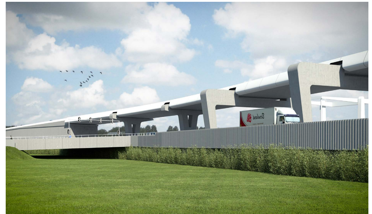
beeld van de nieuwe fly-over met op maaiveldniveau de betonnen borstwering met daaronder bamboeplanten
