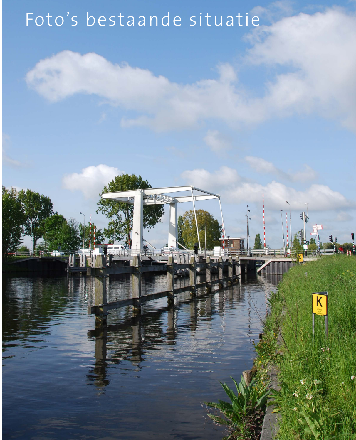
de bestaande ophaalbrug vanaf de oostzijde aan de noordoever
