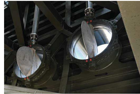
10. Acht nivelleerlepellen staan tijdens het bewegen van de roldeur in gesloten positie.
