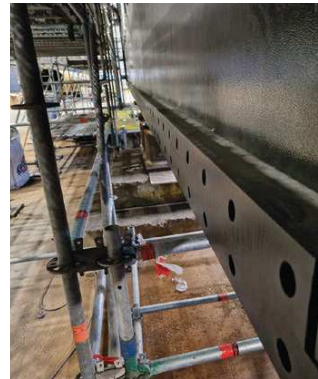
5. Doorbuiging van de verende plaat te begrenzen door een aanslagpunt in achterliggende stijen.
