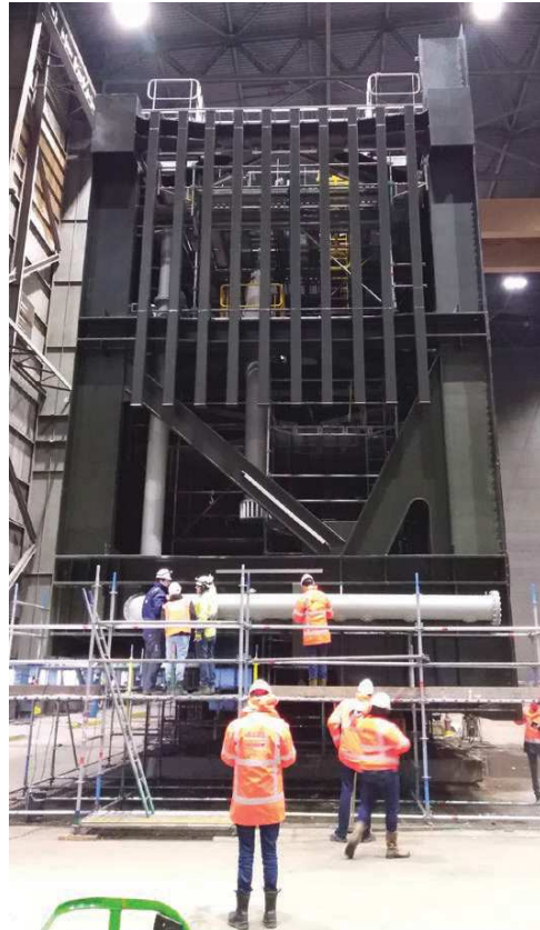
9a en b. Aandrijving sluisdeur (b) en Jetsysteem (a).
