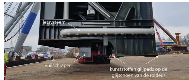
1b. Kops kant met jetsysteem, vuilscraper en glijpads.
