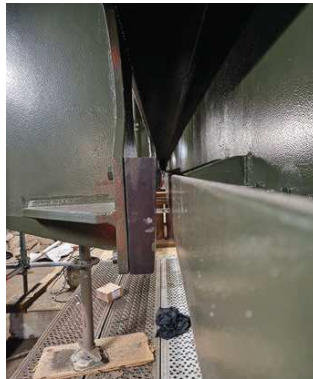
5. Doorbuiging van de verende plaat te begrenzen door een aanslagpunt in achterliggende stijen.
