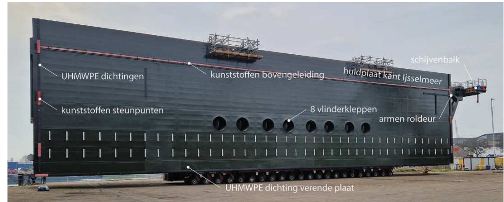
1a. Overzicht met verschillende, belangrijke onderdelen en bewegingsmiddelen.
