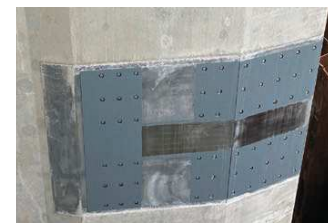
3. Ondergeleiding (b) en bovengleiding (o) met vervangbare staalplaten met Inconel cladding.
