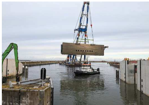
18. Installatie met de Matador 3.
