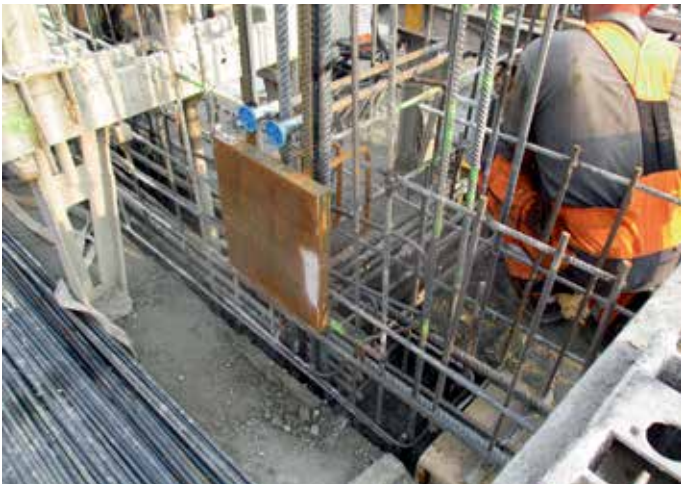
5. Embed plate vastgemaakt aan wapening betonnen kern.
