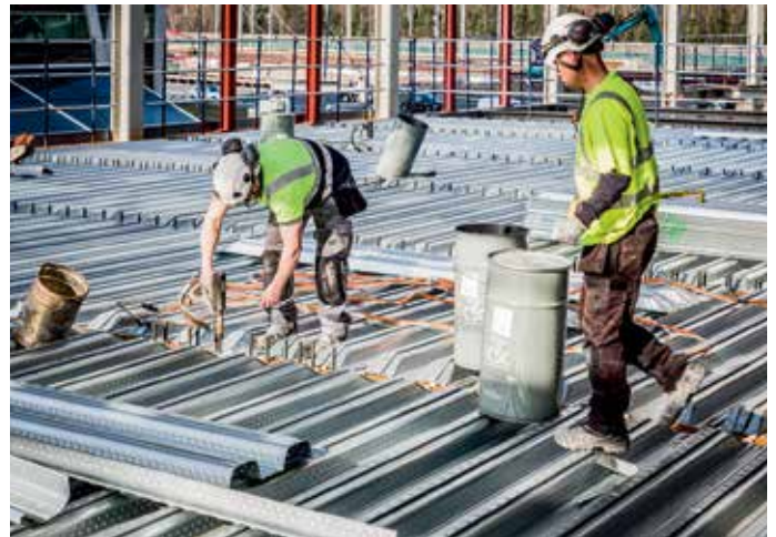
6. Leggen staalplaat-betonvloeren.
