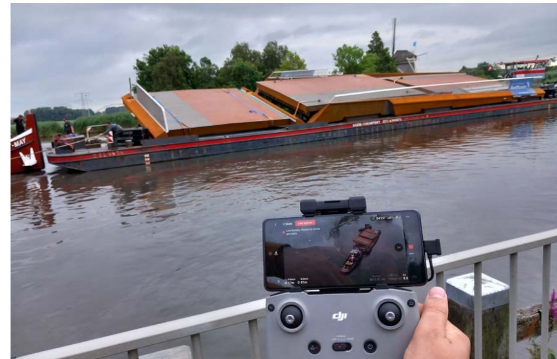
Tijdens het transport was de brug uit alle hoeken (zelfs uit de lucht!) goed in de gaten gehouden en trekt het veel bekijks van toeschouwers. Vooral bij de passage van de Diemerbrug waar enkele landverkeersseinen, leuningen en scheepvaartseinen moeten worden gedemonteerd, was er veel publiek. Op deze foto zien we ook de twee aanbruggen, waarvan de rechtse later precies tussen het beweegbare deel valt.
