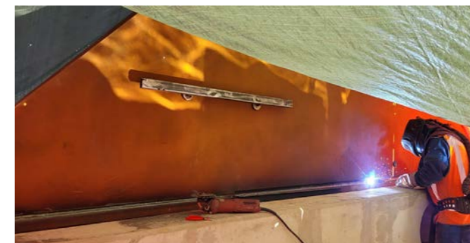
Op locatie worden alle delen weer geplaatst met een 650 tons-kraan met beweegbaar jib van Mammoet. Na het plaatsen van alles delen (eerst de aanbruggen, daarna de ballastkist op de draaipunten en als laatste het beweegbare deel) worden het beweegbare deel en de ballastkist uitgelijnd en opgevijseld. Vier lassers hebben daarna in 12 uur de twee enorme delen aan elkaar gelast op locatie.
