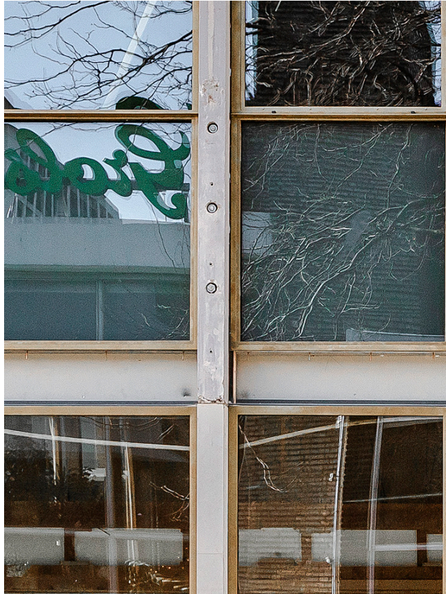
Koppeling tussen bestaande en nieuwe betonpenant
