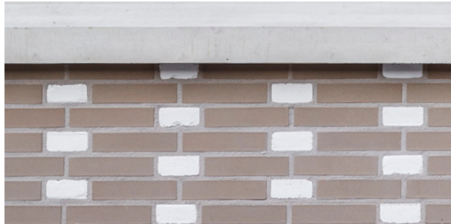
Kettingverband met geglazuurde koppen van handvormstenen en strekken bestaande uit strengpersstenen
