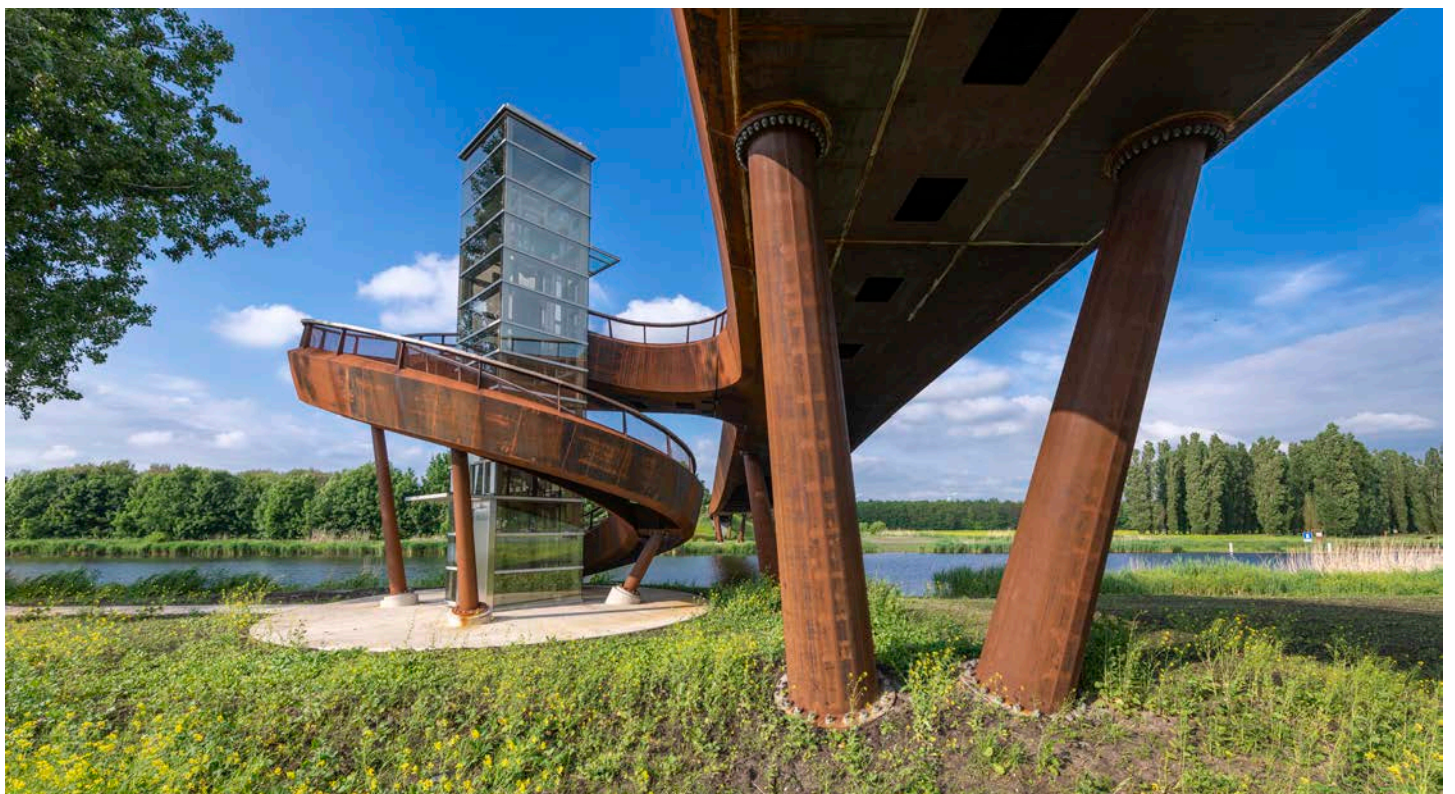
DE SPILTRAP EN DE LIFT WAAR HIJ ZICH OMHEEN WINDT, ONTSLUITEN DE BUSHALTE TUSSEN DE VAART EN DE WEG
