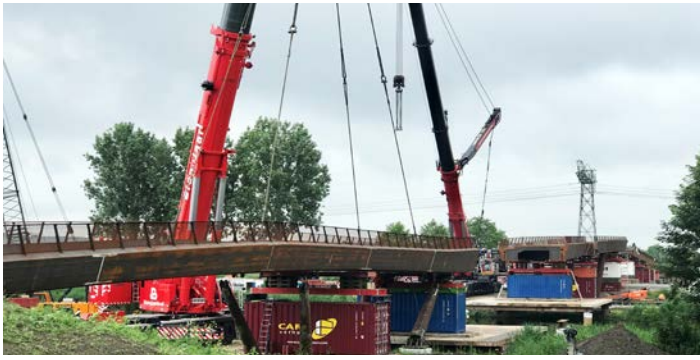
INHJSEN VAN DE BRUGSEGMENTEN OP DE TIJDELIJKE ONDERSTEUNINGEN
