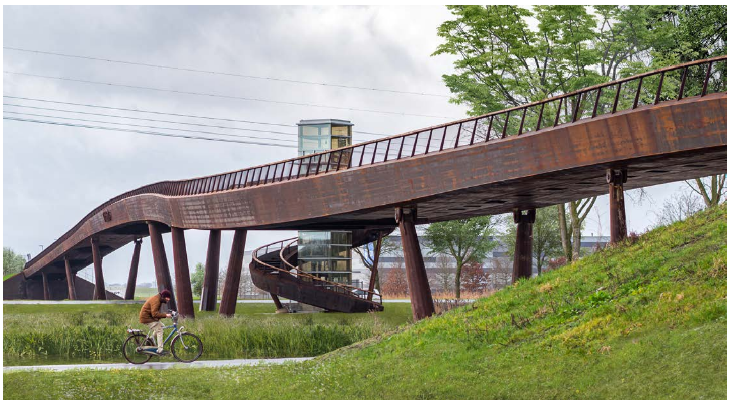
DE GLOOIENDE VORMGEVING VAN DE BRUG IS UNIEK EN EEN KUNSTSTUK IN CONSTRUCTIE EN UITVOERING
