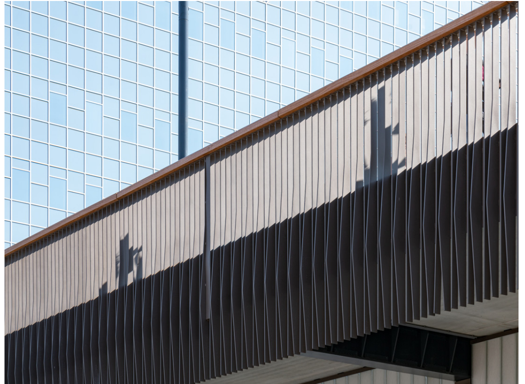
De balustrade is opgebouwd uit individuele stalen lamellen die om en om van elkaar verschillen.
