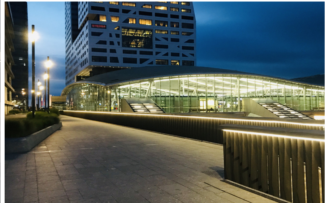
De aan de bovenzijde van de balustrade ingebouwde LED verlichting loopt als een lint om het Forum.
