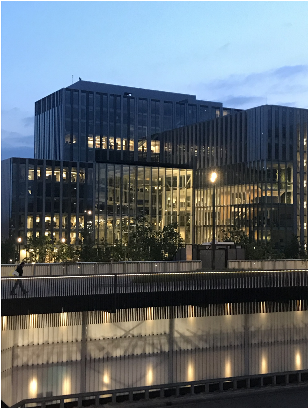
De aan de bovenzijde van de balustrade ingebouwde LED verlichting loopt als een lint om het Forum.
