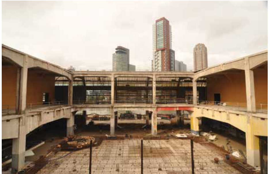
7. Overzicht fundering binnen het bestaande gebouw.
