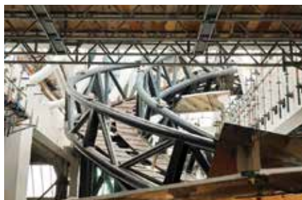
Montage panelen onderzijde spaceframe (met o.m. drukkers en takels) dat uitmondt op het dak.
