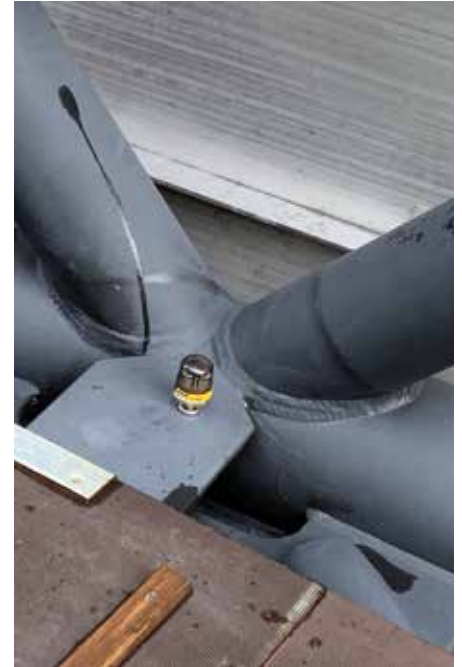
6. Sensor bevestigd aan constructie.
