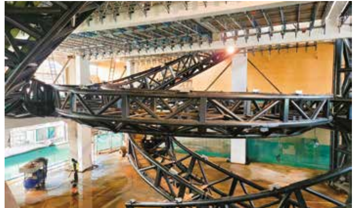
Constructie onderdaks is afgelast en afgeschilderd voor start montage roestvast stalen bekleding. Bovenin: werkvloer voor glasdak.
