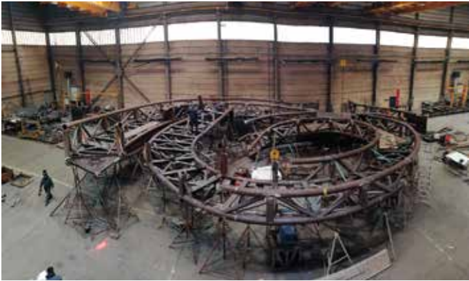
Productieopstelling (of -aanleg). Alle transportsecties (hier zes) zijn in een vormontage geassembleerd voor zuivere passing op de bouwplaats. Dit betreft het deel (innerspine) met de grootste uitkraging. Rechtsboven komt de liftschacht. Links is de uitmonding bovendaks.
