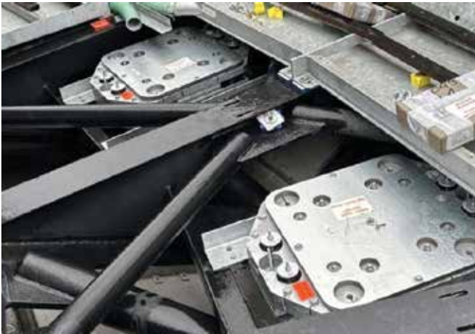
7. Geïnstalleerde TMD (foto: Gerb).
