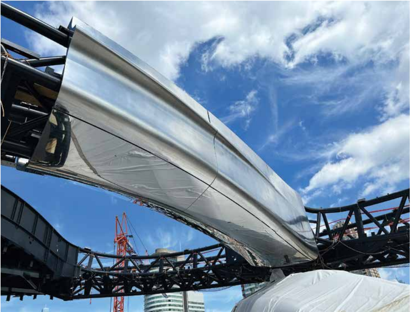
Hier geen beschermfolie op de panelen, maar een gematteerde afwerking vanwege brandveiligheid.
