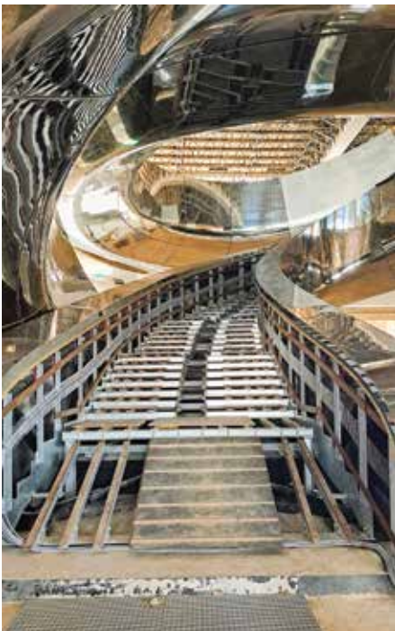
'Fast lane' geheel rvs omhuld. Start houten afwerking.
