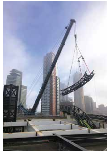
Lobbybox gereed. Rechtsonder: laatste sectie van de slow lane. In de kraan: eerste sectie fast lane (links). Secties zijn ingehesen met een vast punt en twee elektrische takels op afstandsbediening.
