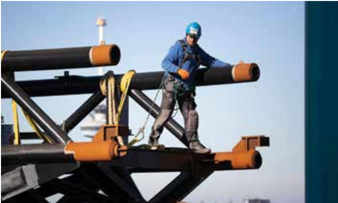
Spaceframesectie bovendaks. Alle secties worden doorgelast met een 'kroon' in de onderbuis die schuift in het aansluitend profiel van de volgende. Na montage worden verbindingen gebout en tijdelijk ondersteund om af te lassen.
