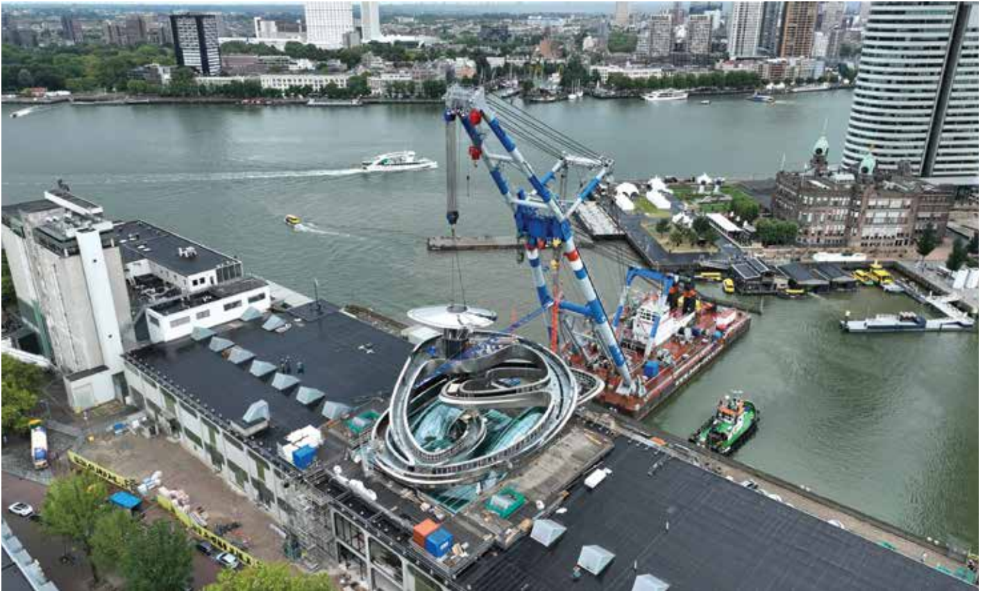
Luifel is voorgemonteerd op een kadeflocatie op Heiplaat en vanaf ponton ingehesen door Matador 3.
