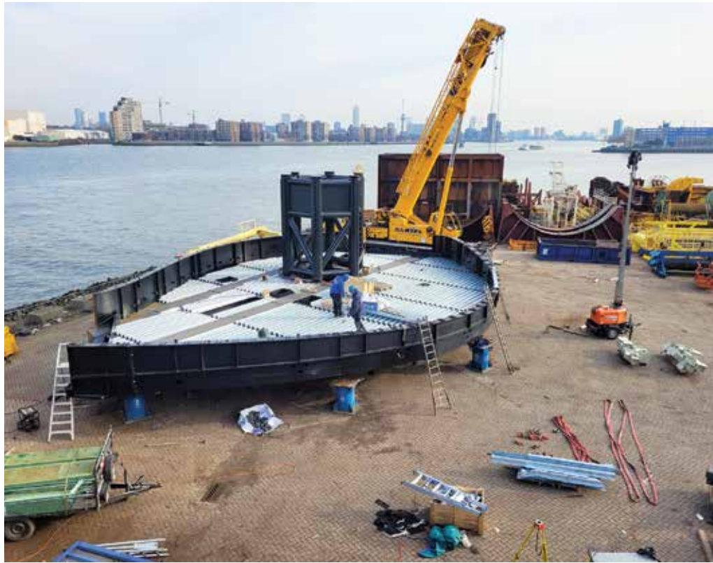
Voormontage uitkijkplatform op dezelfde kadelocatie (Heiplaat) waar de luifel is samengesteld.
