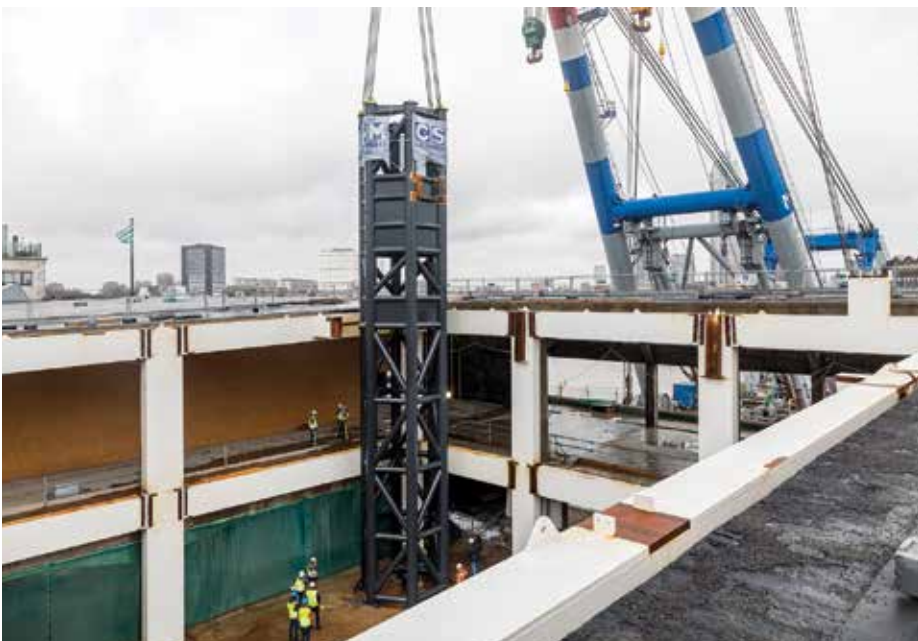
...daarna per ponton naar Fenix II om in één keer in te hijsen...
