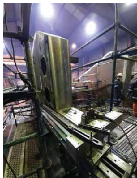
In het val zijn zijn haakse hoeken gefreesd.
