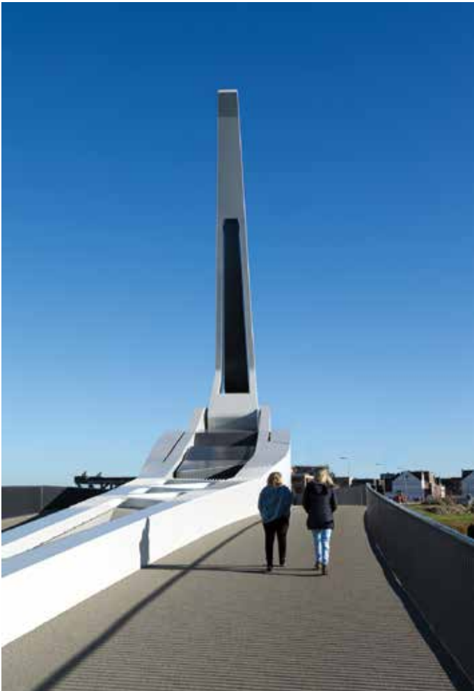
De draagconstructie bevindt zich in het midden van het dek...
