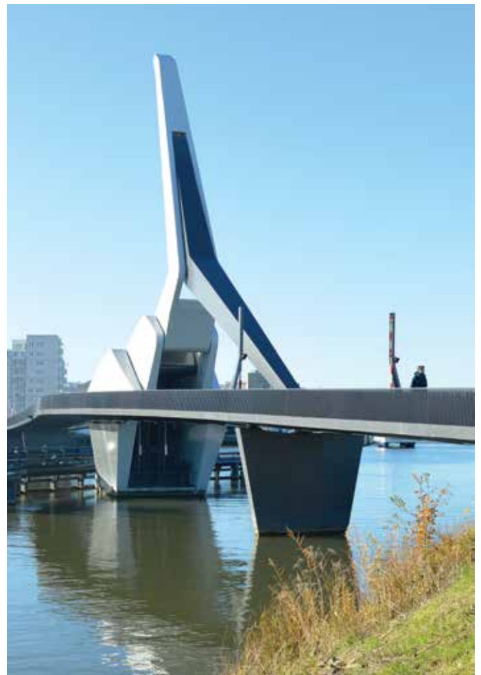
Beide aandrijfcilinders mogen gezien worden en staan daarom buiten de kelder.
