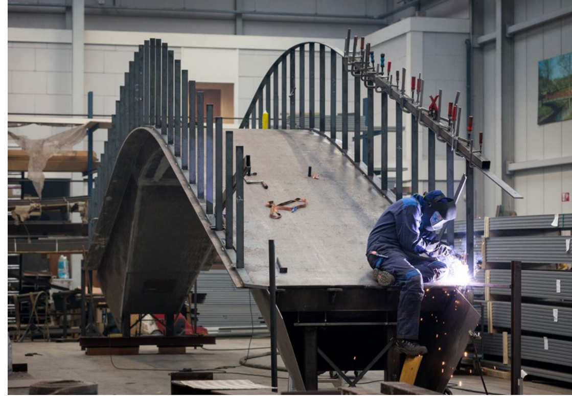
Voor het transport zijn de relingen van de brug gehaald.
