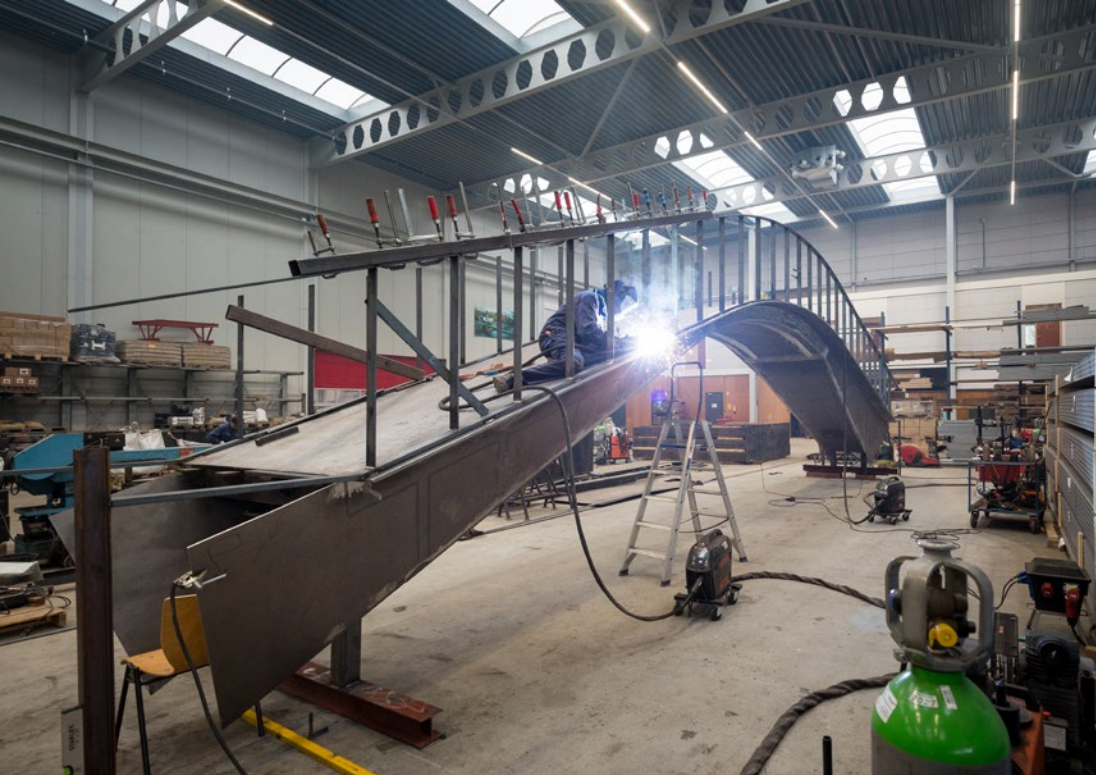
In de werkplaats zijn ook de relingen op maat gemaakt. Deze werden aanvankelijk aan de brug vastgezet om de bolling optimaal te construeren.
