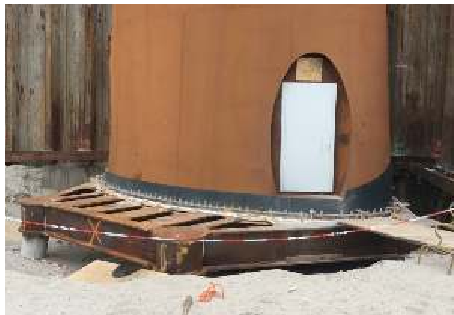
FUNDERING | koppeling van de buizen en fundering Koppeling van het staal en de fundering volgens rapport constructeur.
