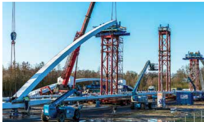
...en daarna ingehesen op drie tijdelijke torens op de voorbouwlocatie.
