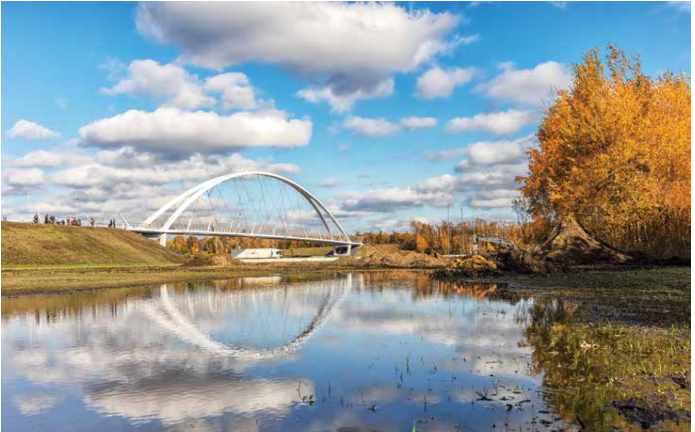
De brug ligt op ruim 7 m boven de rijksweg. Een berekening op aanrijding kan hierdoor achterwege blijven, behoudens bij de afrit van de N2.
