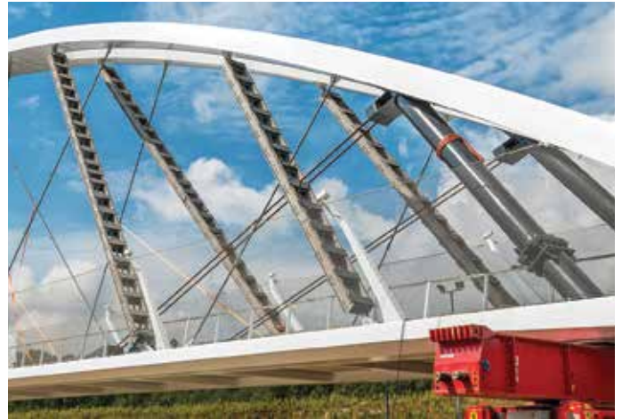
Hulpwerk: drukstaven, knikversterking hangers en trekstaven.
